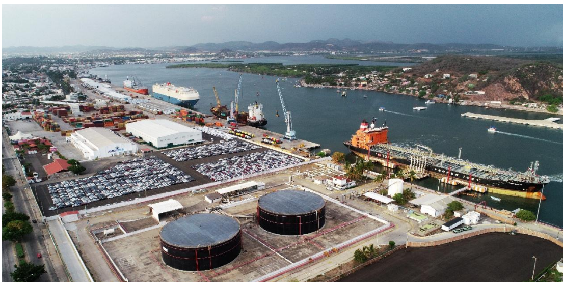
Figura 2.16 Tanques de almacenamiento de combustible
