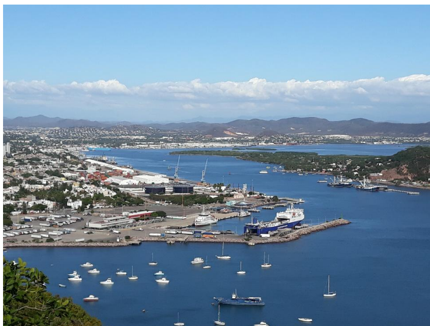
Figura 2.18 Vista de la terminal de transbordadores desde el Faro El Crestón
