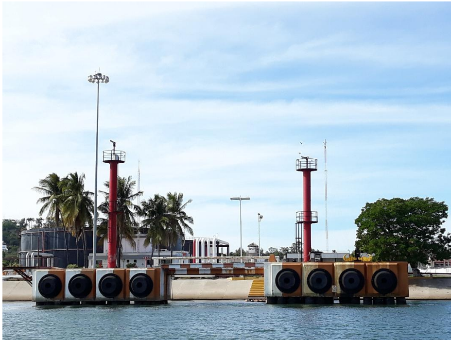
Figura 2.15 Terminal de fluidos
