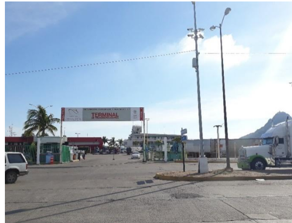
Figura 2.12 Terminal de Transbordadores
