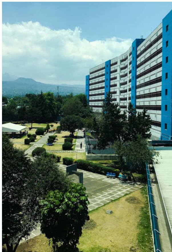
Imagen no. 80. Extraída de: Google (s.f.). Vista al oriente del hospital Fray Bernardino Álvarez. Ciudad de México. Recuperado el 4 de junio de 2018 de www.google.es/maps . Autor: Caliel Jasso.
