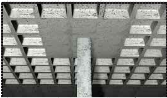
1. Imagen de losa casetonada
