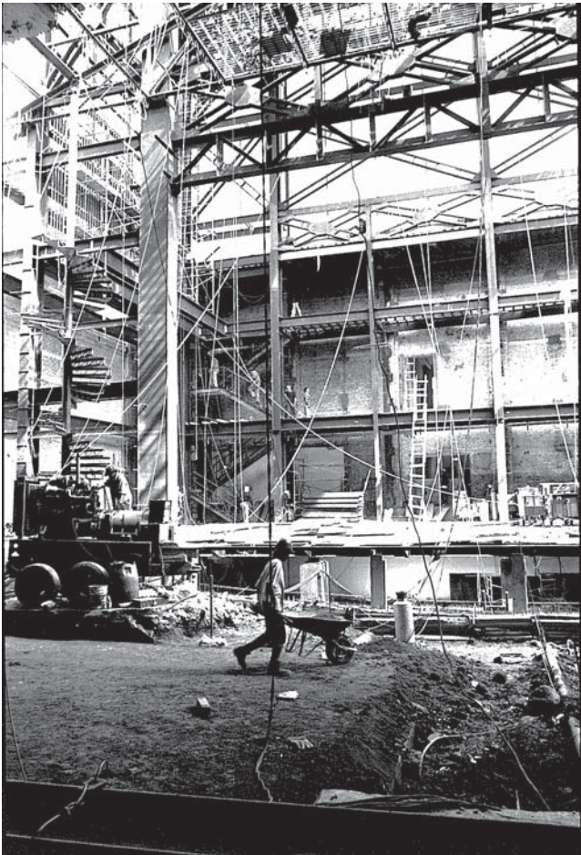
Figura 2.11 Construcción de la caja escénica Foto: Lorena Campbell Cortesía: Moyao Arquitectos
