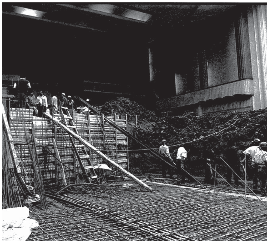
Figura 2.8 Construcción Foso de Orquesta Foto: Lorena Campbell Cortesía: Moyao Arquitectos
