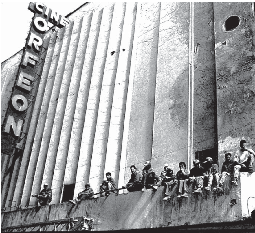
Figura 2.5 Fachada Cine Orfeón Foto: Lorena Campbell Cortesía: Moyao Arquitectos
