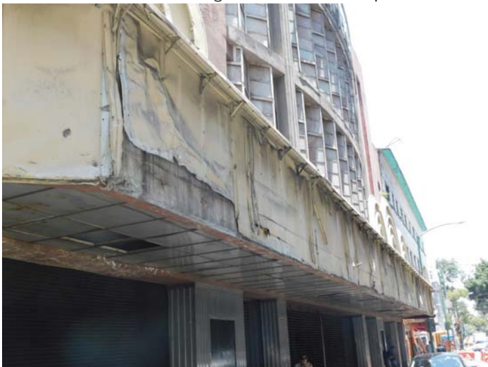
Figura 5.14 Maquesina dañada
