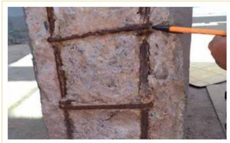
**Figura 2.1. En la imagen se señala la herrumbre formada en las barras de acero reforzado en la columna de concreto armado**
