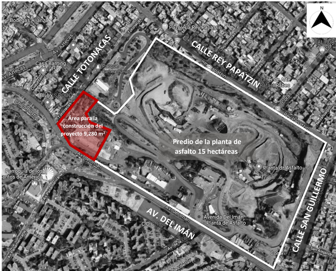
Figura 3. Vista aérea del terreno, el predio de la planta de asfalto es representado por la poligonal de color blanco y el área resaltada en color rojo será destinada para la construcción del proyecto.
