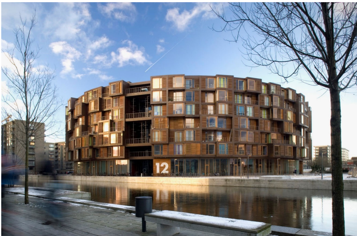
Figura 17. Fachada de los dormitorios a un costado del canal.
