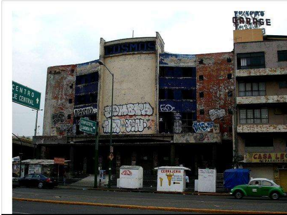
Fachada principal del Cine Cosmos en 2013.
