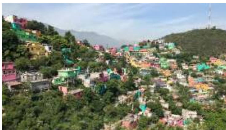
Imagen 9. Colonia Independencia, Monterrey, NL. Cambio de imagen de fachadas mediante el programa "Transformando Monterrey". Fuente: ©Elided Hernández Acosta 2019-Archivo de trabajo de campo.
