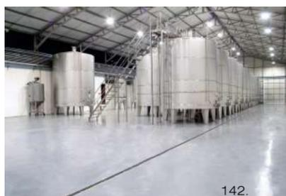
Los acabados en pisos son de acuerdo al tipo de espacio y actividad que se desarrolla en su interior. En el área de producción y cuartos de máquinas se utiliza un piso epóxico color gris antiderrapante, así como un zoclo epóxico sanitario con curvatura de 5 cm. Se eligió este tipo de acabado para garantizar la mayor sanidad y uniformidad en los niveles del área así como un fácil mantenimiento.
