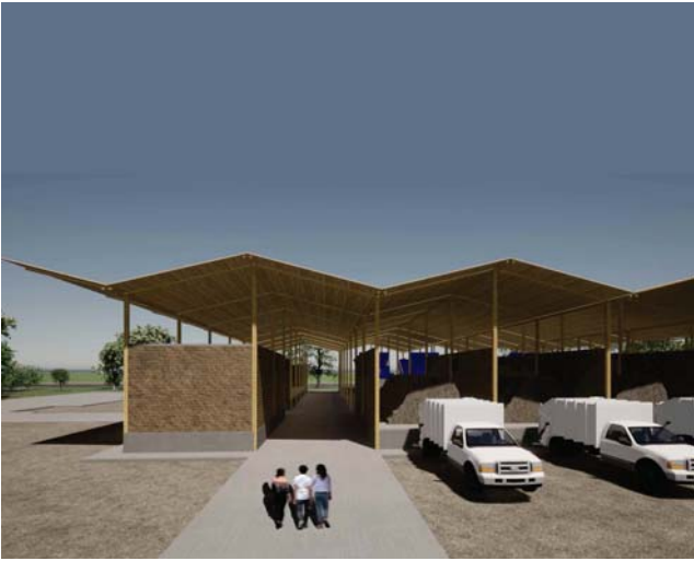
6.4 Acceso nave industrial de producción de composta Fuente: Elaboración propia
