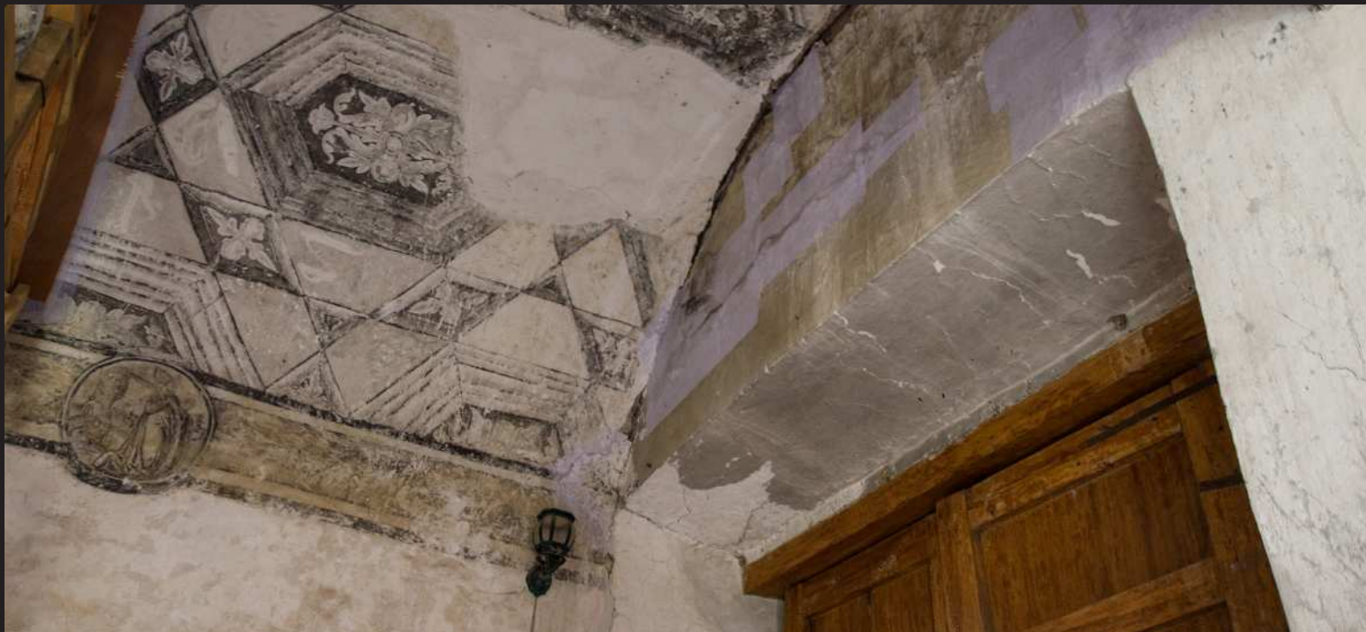
Fotografía 70. Pasillo del Ex convento de San Guillermo Totolapan Fotografía: Laura Casariego (2018)
