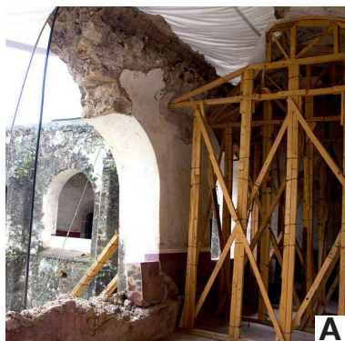
Lámina 30. Daños localizados en Corte G-G'
