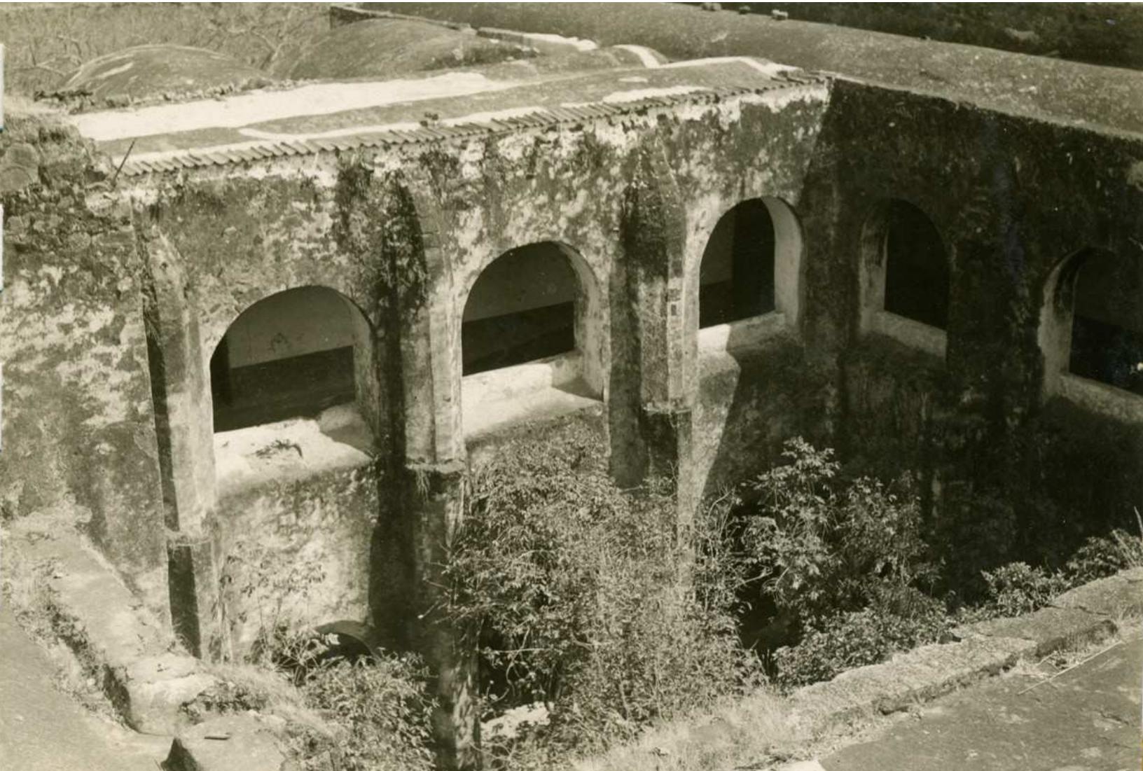
Fotografía 36. Interior del Claustro Archivo fotográfico cnmh
