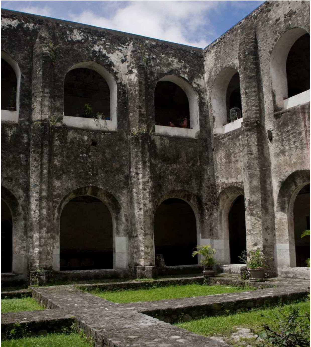
Fotografía 37. Interior del Claustro [Foto: Pinhole Art](Morelos, 2011) recuperdo de: https://cutt.ly/0rlCMyw
