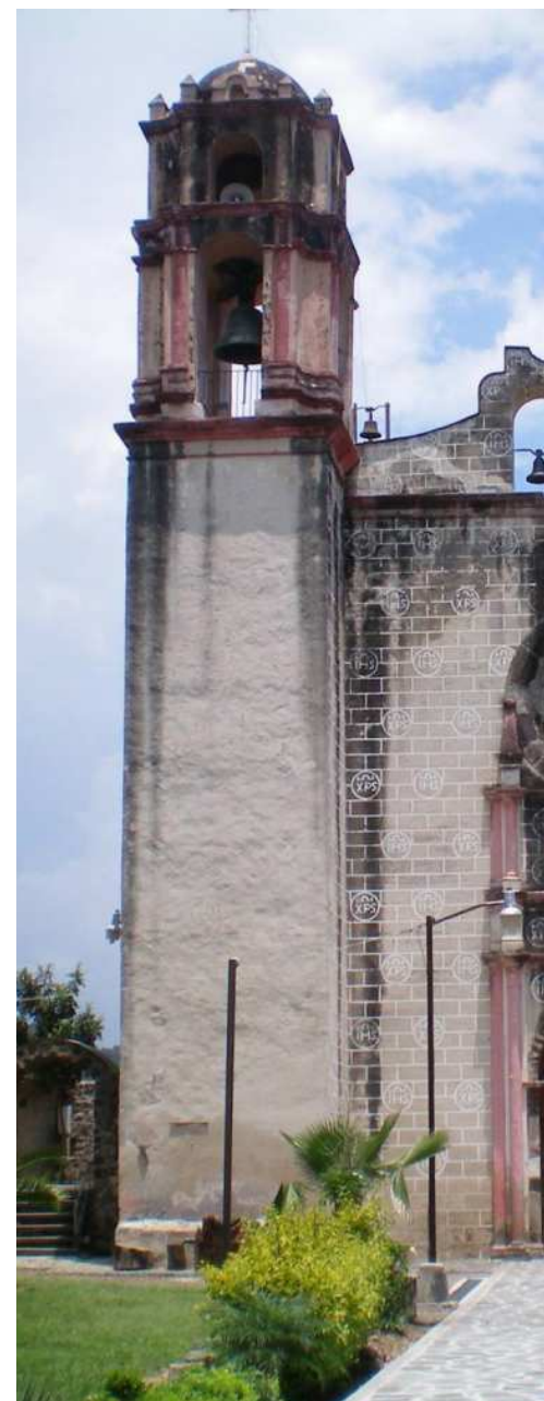
Fotografía 50. Portada del Convento de San Guillermo Totolapan [Foto: Anónimo]. (Totolapan, 2015) Recuperado de: https://cutt.ly/mrVHGa6
