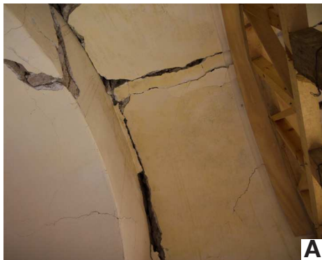
Lámina 29. Daños localizados en Corte D-D'
