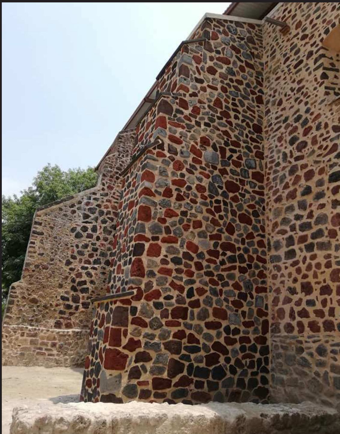
Fotografía 94. Contrafuertes de templo del Ex convento de San Guillermo Totolapan
