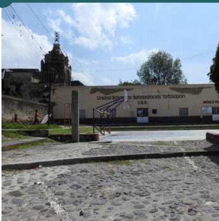
Fotografía 44. Escuela Construída en Barda del Atrio
