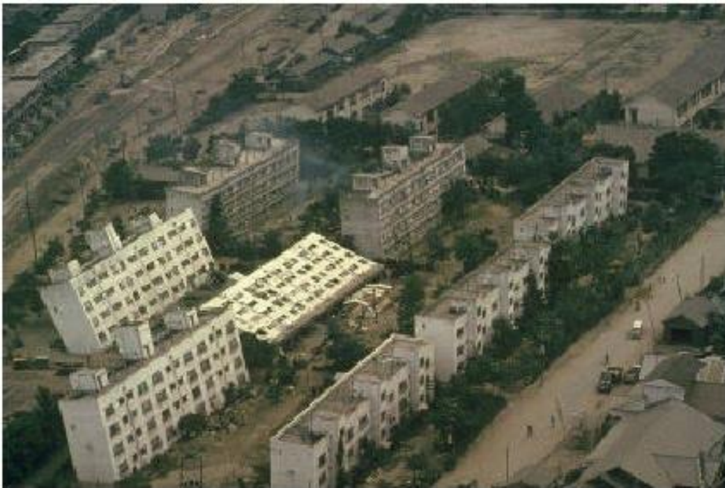
Figura 1.12. Falla por pérdida de capacidad de carga de edificios de departamentos de Kawagishi-cho, sismo de Niigata, 1964.
