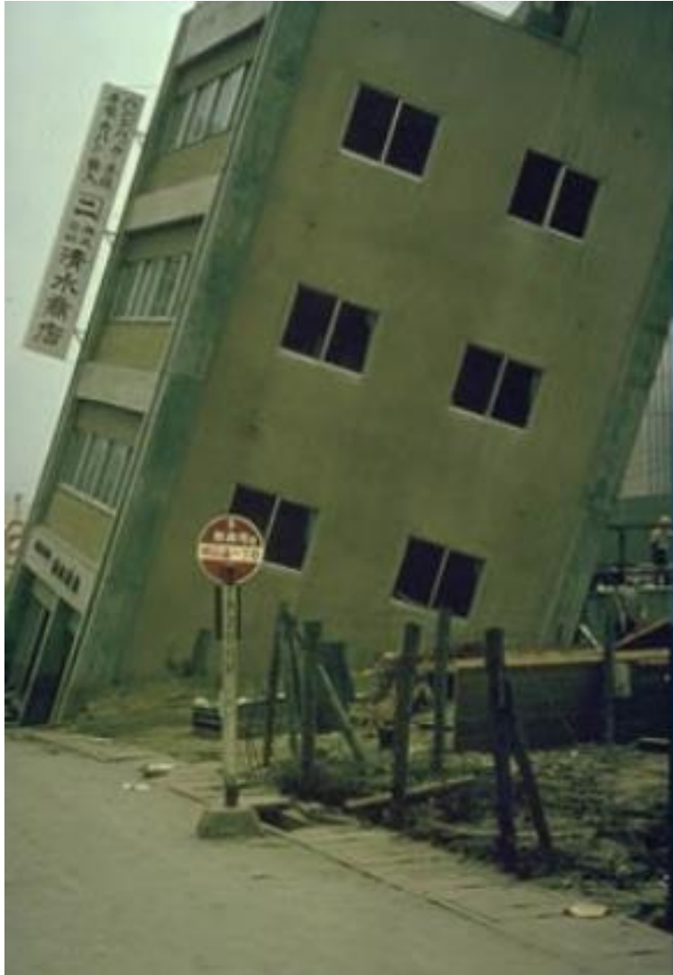
Figura 1.13. Asentamiento en edificio, sismo de Niigata, 1964.
