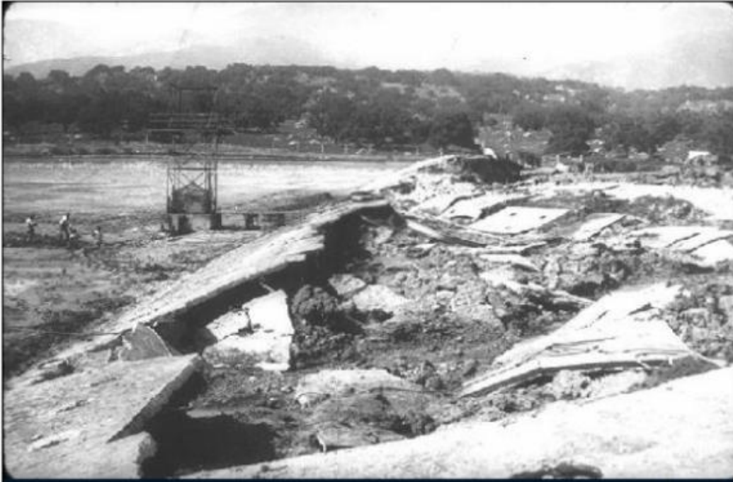
Figura 1.6. Deslizamiento por flujo de la presa Sheffield, sismo de Santa Bárbara.1925.
