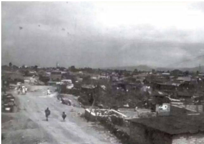
Construcción de viviendas en Pedregal de Santo Domingo Fototeca Nacional
