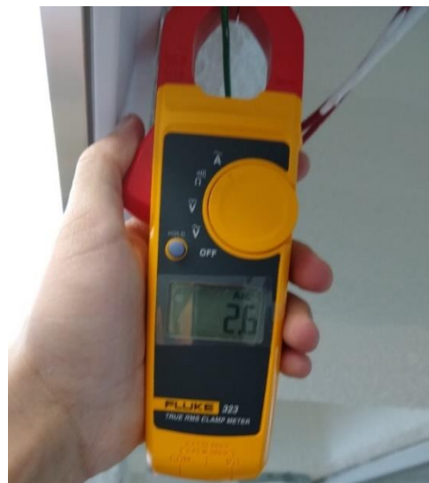
Figura 11. Corriente en luminaria fluorescente 2 Fotografía tomada en el Laboratorio L3.
