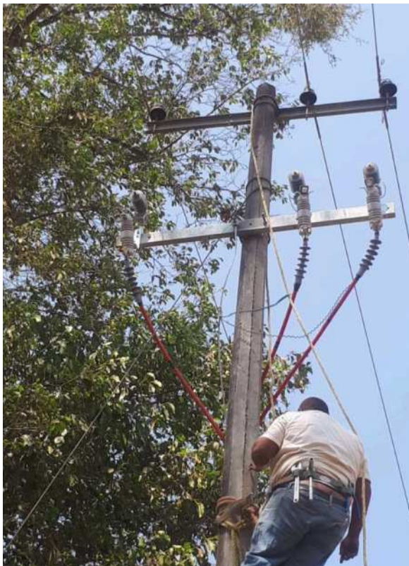
Imagen C. 47. Colocación de los accesorios para la vestimenta del poste. Aquí se hizo la conexión a la línea de distribución.
