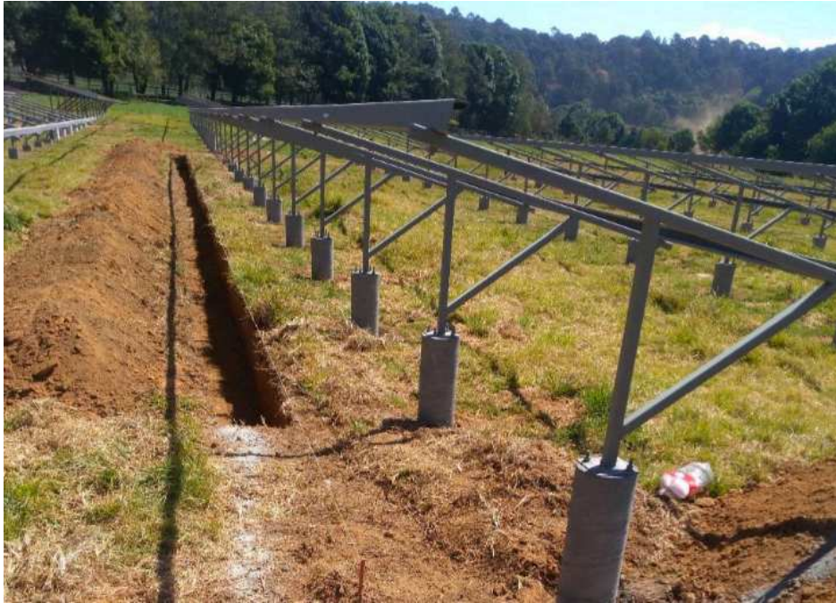
Imagen C.40. Trazo y excavación de las zanjas para las canalizaciones tanto de corriente directa como de corriente alterna.
