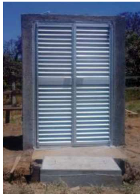
Imagen C. 45. Construcción del nicho que aloja el tablero de protección. Recibirá la corriente generada por los 3 inversores y por medio de la salida e interruptor principal a un voltaje de 480 V alimentará el transformador de 225 KVA (Volts-Amperes). Se añadió una puerta de aluminio.
