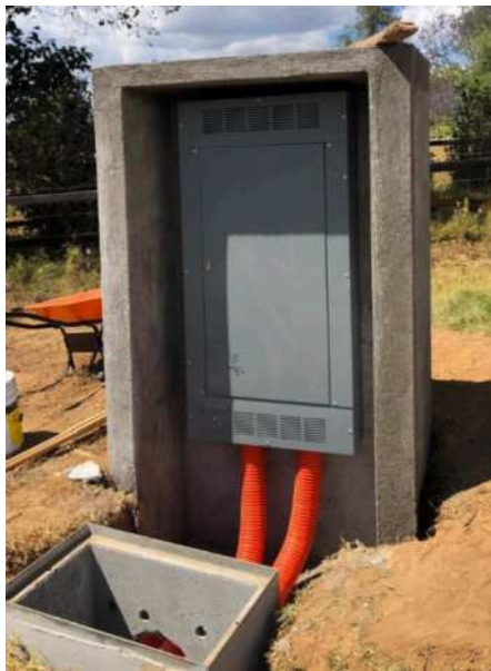
Imagen C. 45. Construcción del nicho que aloja el tablero de protección. Recibirá la corriente generada por los 3 inversores y por medio de la salida e interruptor principal a un voltaje de 480 V alimentará el transformador de 225 KVA (Volts-Amperes). Se añadió una puerta de aluminio.
