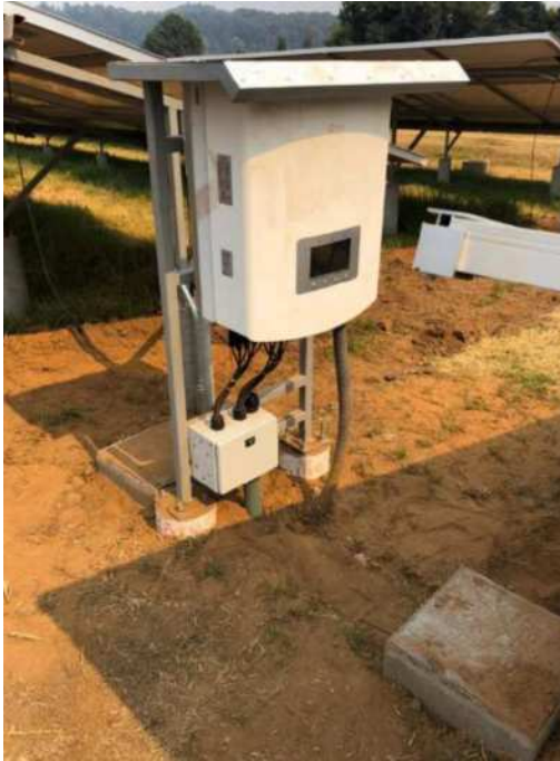
Imagen C. 45. Construcción del nicho que aloja el tablero de protección. Recibirá la corriente generada por los 3 inversores y por medio de la salida e interruptor principal a un voltaje de 480 V alimentará el transformador de 225 KVA (Volts-Amperes). Se añadió una puerta de aluminio.
