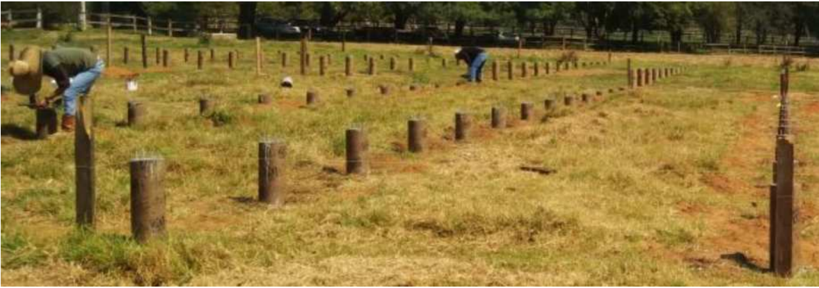
Imagen C.38. Colado de las bases.
