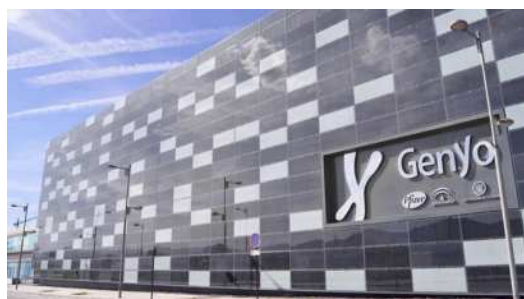
Imagen C. 50. Centro de Genómica e Investigación Oncológica (GENyO) en la Universidad de Granada, España. Fachada fotovoltaica diseñada por la empresa Onyx Solar. Genera 32 MWh/año.
