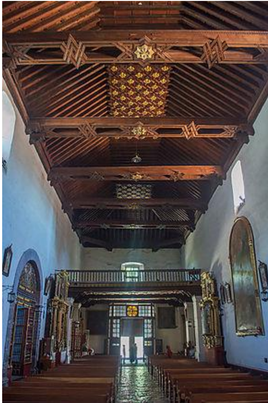
41. Interior de la Catedral de Nuestra Señora de la Asunción, en Tlaxcala. Fuente: https://es.wikipedia.org/wiki/Ciudad_novohispana_de_Tlaxcala . Fecha de consulta 19 de abril de 2018. Se puede apreciar la cubierta de estilo mudéjar del tipo de "par y nudillo". Los tirantes se encuentran decorados con ornamentación de lazo y con estrellas al medio de a ocho puntas.
