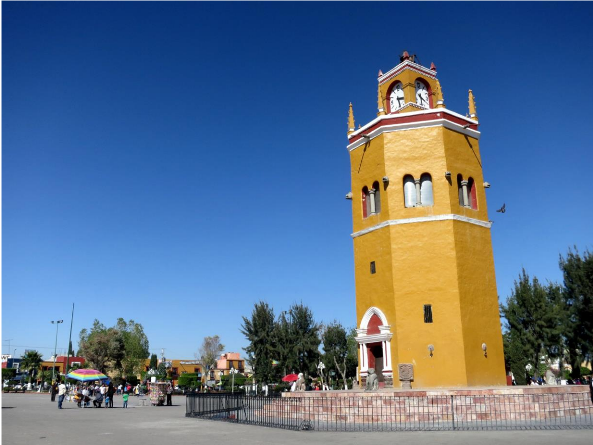
14. Torre del reloj "El Rollo", en Tepeaca, Puebla. Fuente: http://elevation.maplogs.com/poi/de_la_manzana_san_juan_acozac_los_reyes_de_ju_rez_pue_mexico.26022.html . Fecha de consulta 8 de mayo de 2018.
