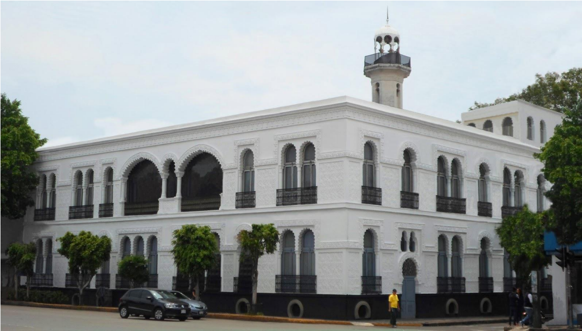
17. Antigua Casa Serralde o Casa Morisca, ubicada en Mixcoac, Ciudad de México. Fuente: https://grandescasasdemexico.blogspot.mx/2017/07/casa-serralde-acosta-en-rubens-y.html . Fecha de consulta 8 de mayo de 2018.
