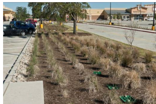
Figura III.XIII. Franja filtrante FUENTE: (Abellán, 2016)
