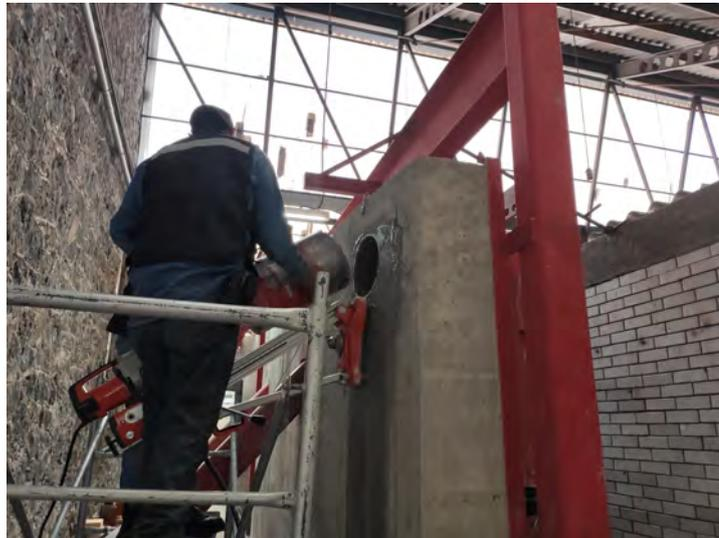
Figura 5.37: Descorazonadora montada en la replica del muro que sujeta el panel
