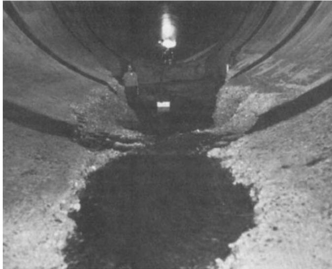
Figura 2.6. Daños por cavitación, túnel de la presa Yellowtail (Arndt, 2003)
