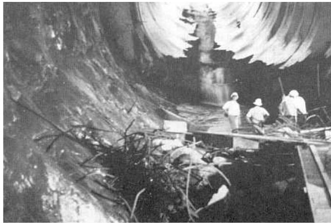
Figura 2.8. Daños por cavitación en túnel derecho, presa Glen Canyon (Falvey, 1990)
