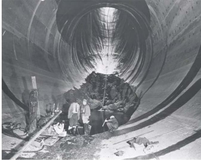
Figura 2.5. Daños provocados por cavitación en el túnel de la presa Hoover (Warren., 2012)
