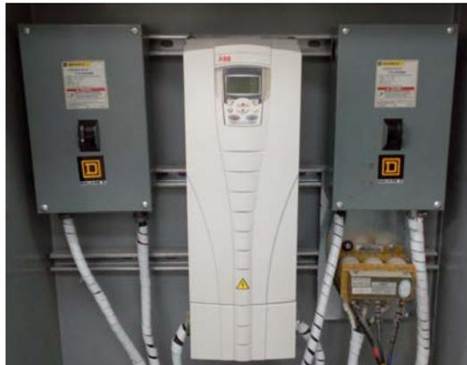
Figura 5.2. Variador de velocidad de la bomba
