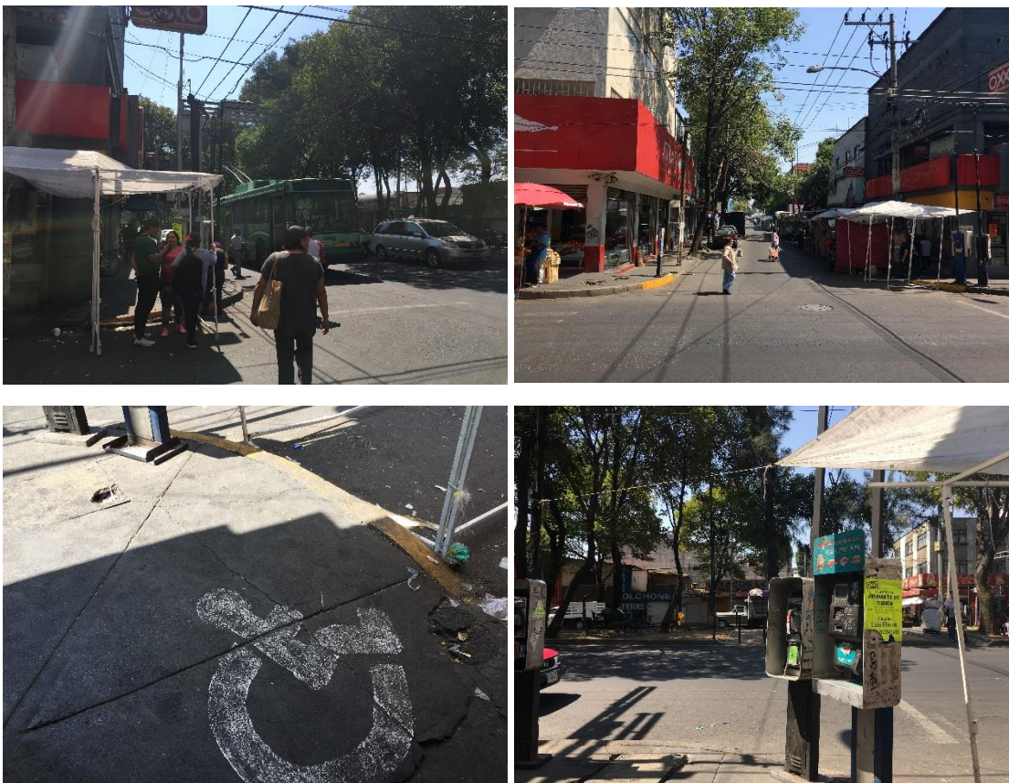
FIGURA 66. Obstrucción de rampas peatonales en la esquina de Calle 12 y Avenida Cuitláhuac. Fuente: Elaboración propia (2019).
