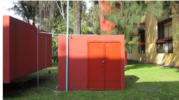
Imagen 3.10 Infraestructura existente dentro de la unidad: Laboratorio de vivienda,FA
