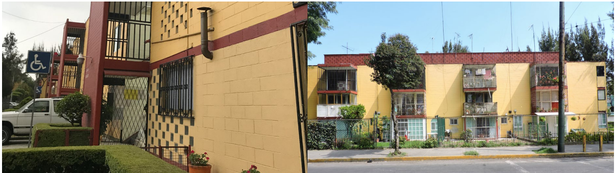
Imagen 3.32 De lado izquierdo vista de edificio multifamiliar tipo B en el se ve la adición de una ventana rompiendo con las celosías originales, de lado derecho vista de los balcones del mismo tipo edificio en el que se observa los cambios de herrería de los balcones cambiando la imagen completamente. Fuente: Una vida moderna y Laboratorio de vivienda, FA
