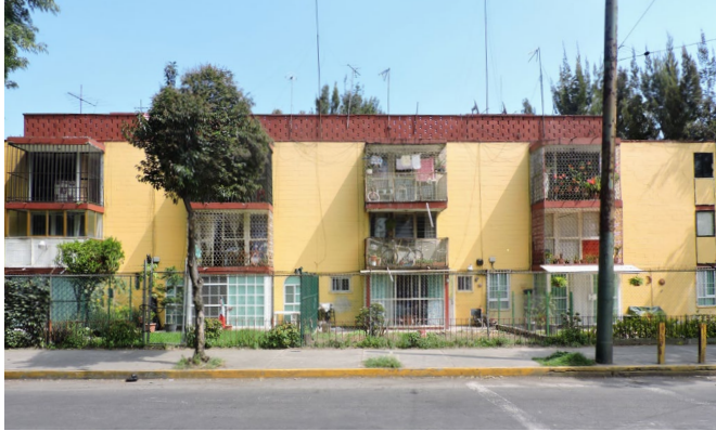
Imagen 3.37 Modificaciones en fachada de edificio tipo B, se observa las modificaciones en los balcones ya sea por herrería o cerrandolo por completo y la apropiación del área verde en planta baja ,2018 Fuente: Laboratorio de Vivienda, FA
