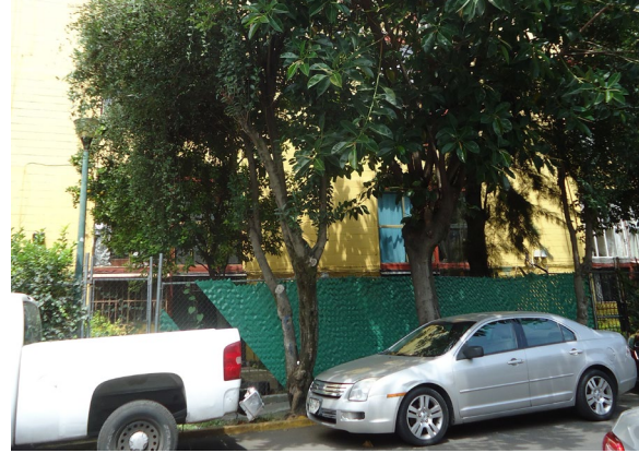
Imagen 3.29 Edificio tipo A en el que se observa la delimitación de las áreas verdes por parte de la vivienda en planta baja Fuente: Laboratorio de Vivienda, FA
