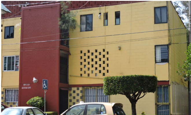
Imagen 3.38 Modificaciones en fachada de edificio tipo B, se observa las modificaciones realizadas en lo que corresponde al patio de servicio, las celosías desaparecen o son sustituidas por ventanas, 2018 Fuente: Laboratorio de Vivienda, FA
