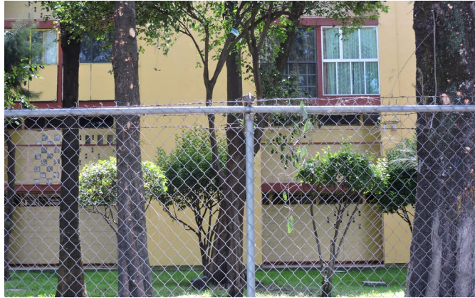
Imagen 3.35 Modificaciones en fachada de edificio tipo A, se observa las modificaciones en celosías y cambio de herreras en ventanas Fuente: Laboratorio de Vivienda, FA
