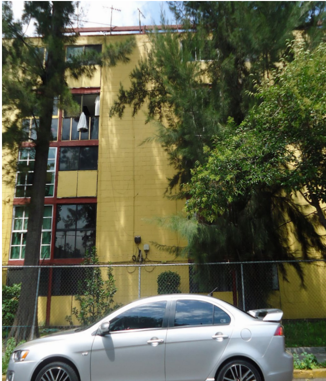
Imagen 3.34 Modificaciones en fachada de edificio tipo A, en el que se observa las ventanas originales y las modificaciones de herrería de las ventanas, 2018 Fuente: Laboratorio de Vivienda, FA
