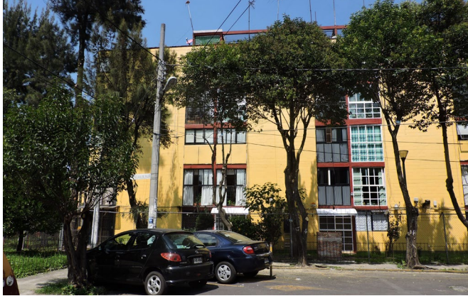
Imagen 3.33 Modificaciones en fachada de edificio tipo A, en el que se observa los cambios en herrería de los ventanales originales y la apropiación de área verde en planta baja, 2018 Fuente: Laboratorio de Vivienda, FA
