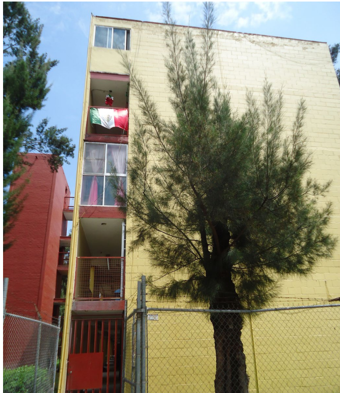
Imagen 3.36 Modificaciones en fachada lateral de edificio tipo A, se observa la ventana original en el 5to nivel y apertura total de la ventana en el 3er nivel Fuente: Laboratorio de Vivienda, FA
