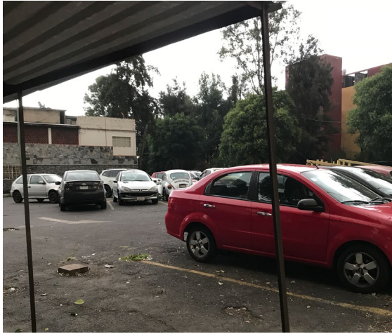
Imagen 3.30 Cajón de estacionamiento delimitado por una cubierta metálica dentro del área de estacionamiento de la unidad. Fuente: Elaboración propia
