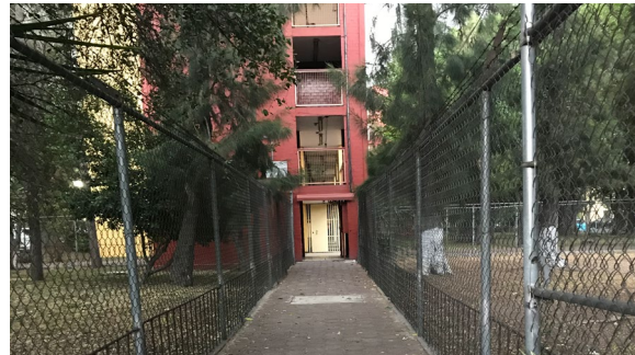
Imagen 3.12 Infraestructura existente dentro de la unidad: Laboratorio de vivienda,FA
