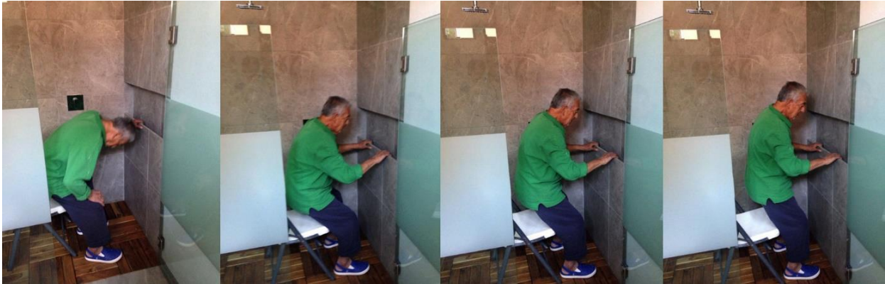
Imagen 4. Regadera de baño de PB después de la remodelación. Se generó un detalle en obra con el cual se pudiera prescindir de los tubos que generalmente se ponen como apoyos. También se colocó madera de Teka en la regadera que brindara mayor confort y comodidad a una persona mayor. Se evitó poner escalón o sardinel para la regadera favoreciendo así su fácil acceso.
