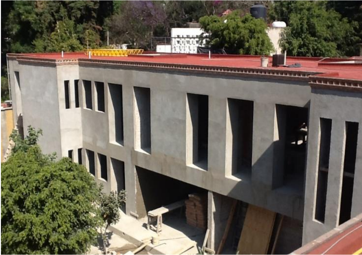
Imagen 4. Fotografía de la fachada principal con vista al jardín en su proceso de ejecución
