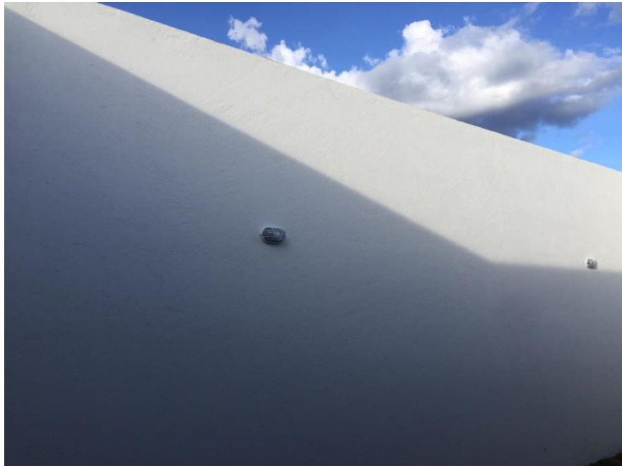
Imagen 4. Vista de muros perimetrales de jardín posterior.
