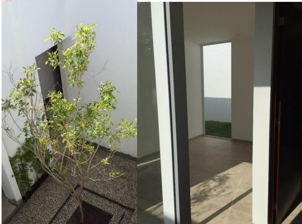
Imagen 4. Patio interior de vivienda. Futuro espacio para ubicación de circulación vertical para desarrollo de segunda planta.
