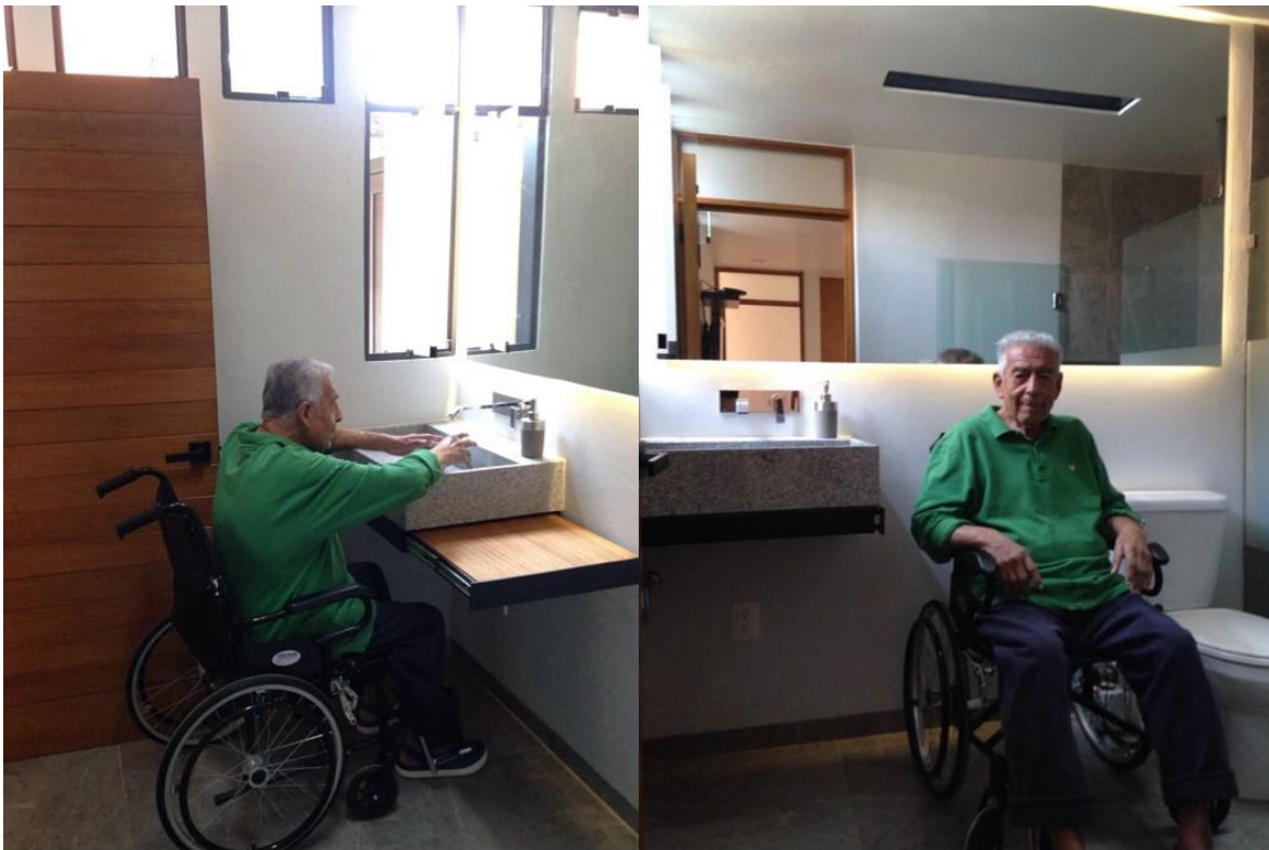
Imagen 4. Imagen de lavabo de PB. Se puede apreciar el funcionamiento del lavabo – tocador. En la primera imagen se observa el mueble desplegado y en la segunda el abatimiento del tocador genera el espacio para la silla de ruedas.
