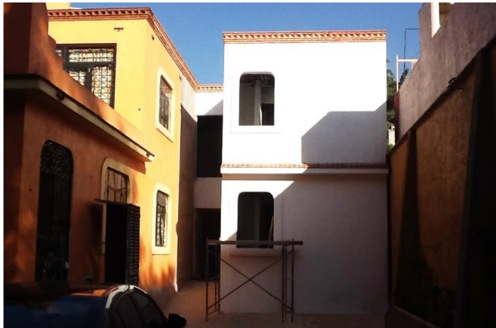
Imagen 4. Fachada de acceso y su proceso de ejecución. En la imagen se puede observar el edificio de oficinas y el vínculo formal con el nuevo proyecto.
