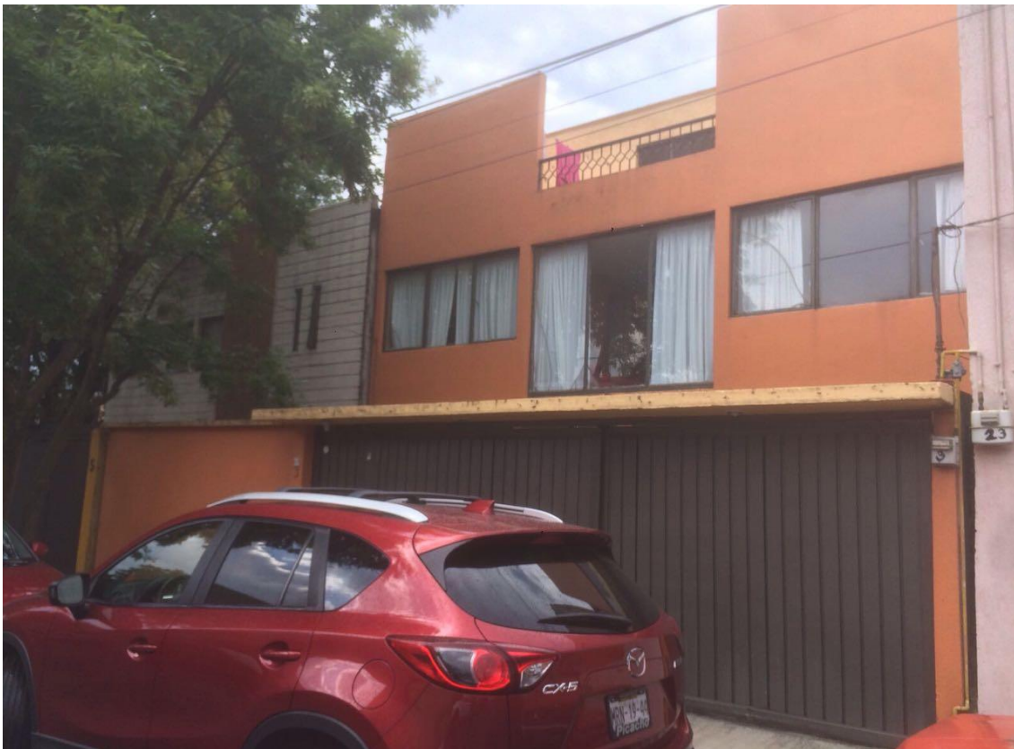
Imagen 4. Estado inicial de la vivienda. Podemos observar que la vivienda no contaba con varias condicionantes como pudiera ser la privacidad, ya que podemos destacar que la mayor parte del tiempo las cortinas de las recamaras están cerradas por la proximidad con el vecino, también se puede distinguir que la orientación de las recamaras no es la ideal.
