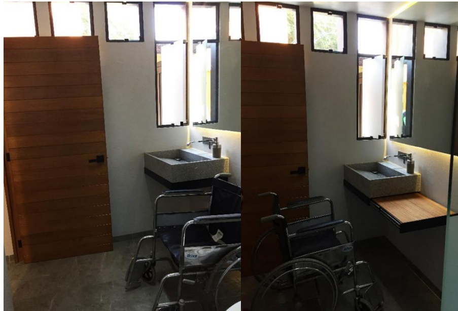
Imagen 4. Baño de recámara PB después de la remodelación, donde se consideraron factores como la adaptabilidad, ciclo de vida del ser humano, accesibilidad, confort y privacidad.
