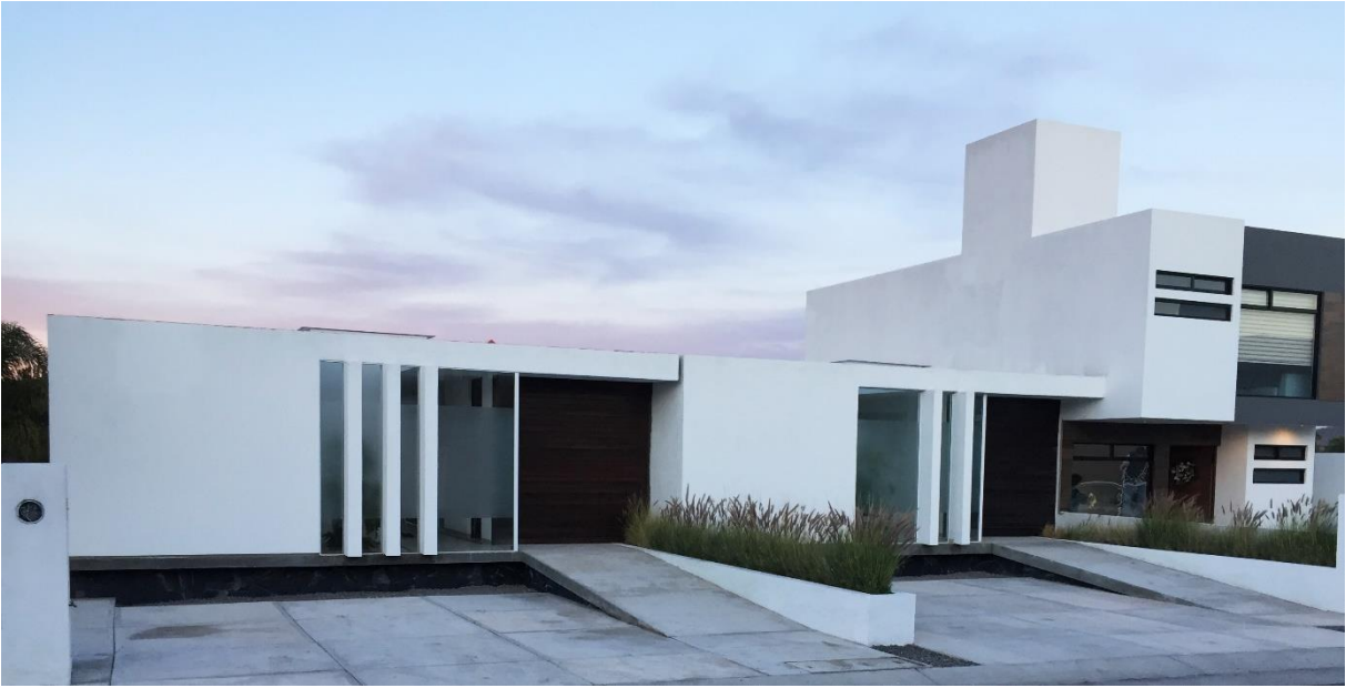
Imagen 4. Fotografía de conjunto.
