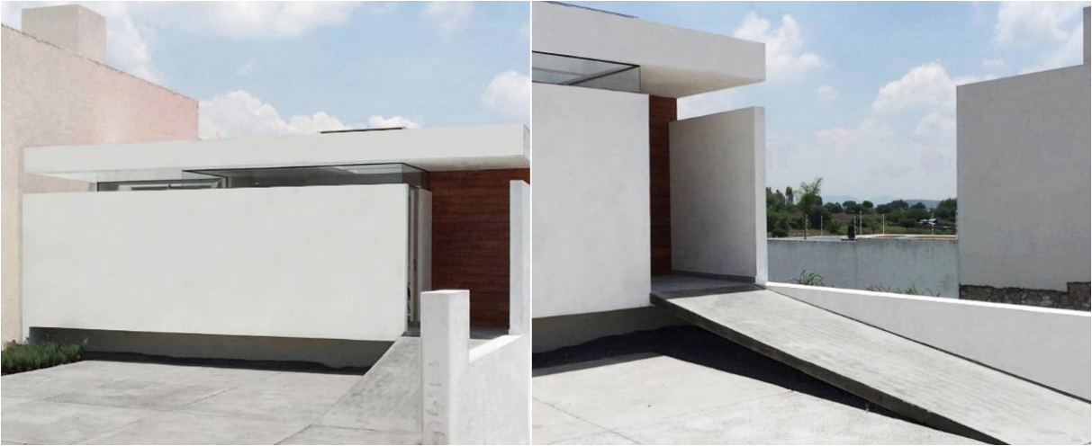
Imagen 4. Imágenes del exterior del edificio. La fotografía se enfoca en la rampa de acceso a la vivienda.
