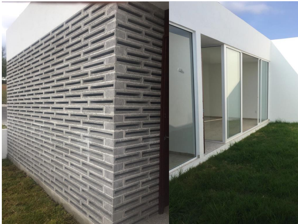
Imagen 4. Detalles generales en fachadas de edificio. Se puede observar en la primera imagen la celosía del cuarto de servicio. En la segunda imagen la vista del área social al jardín posterior.
