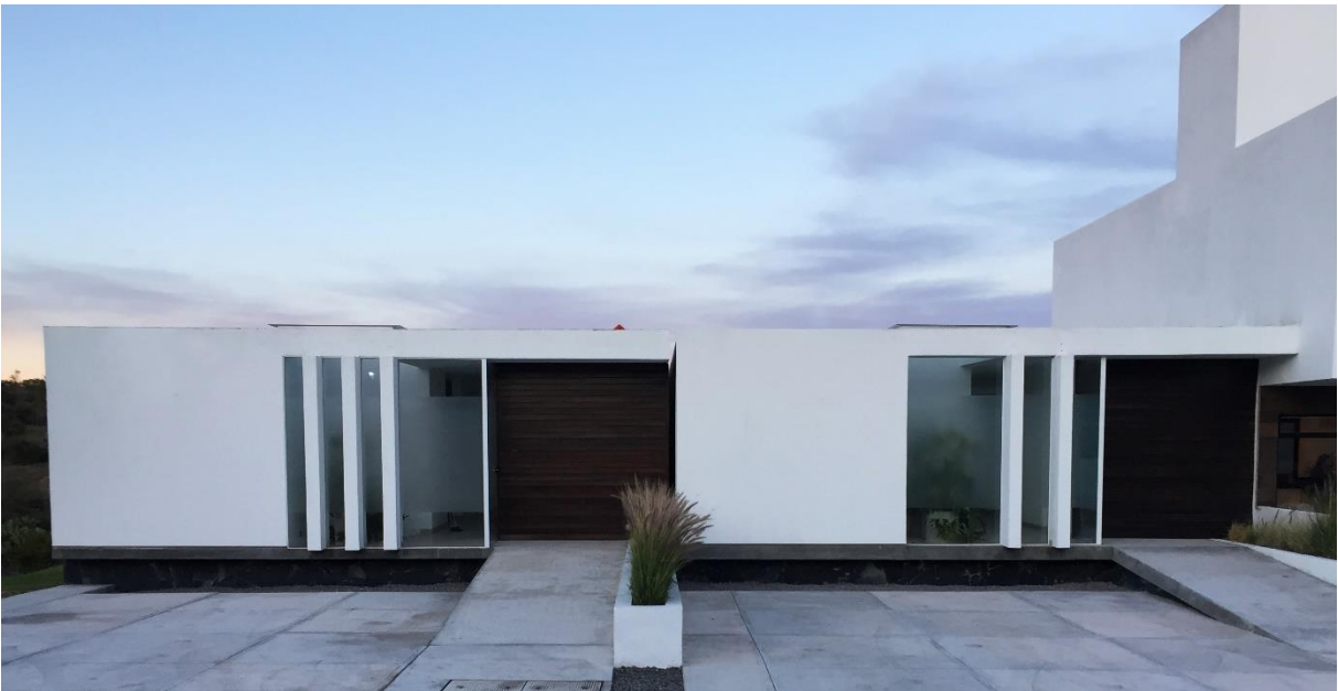
Imagen 4. Fotografía de conjunto donde se pueden observar las rampas de acceso.
