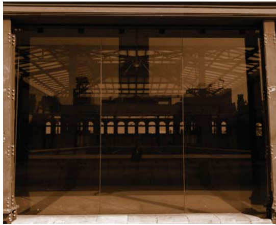
Gráfico 143. Vació en vez de muro; en la remodelación pusieron este enorme ventanal. Foto: Jorge Vázquez.
