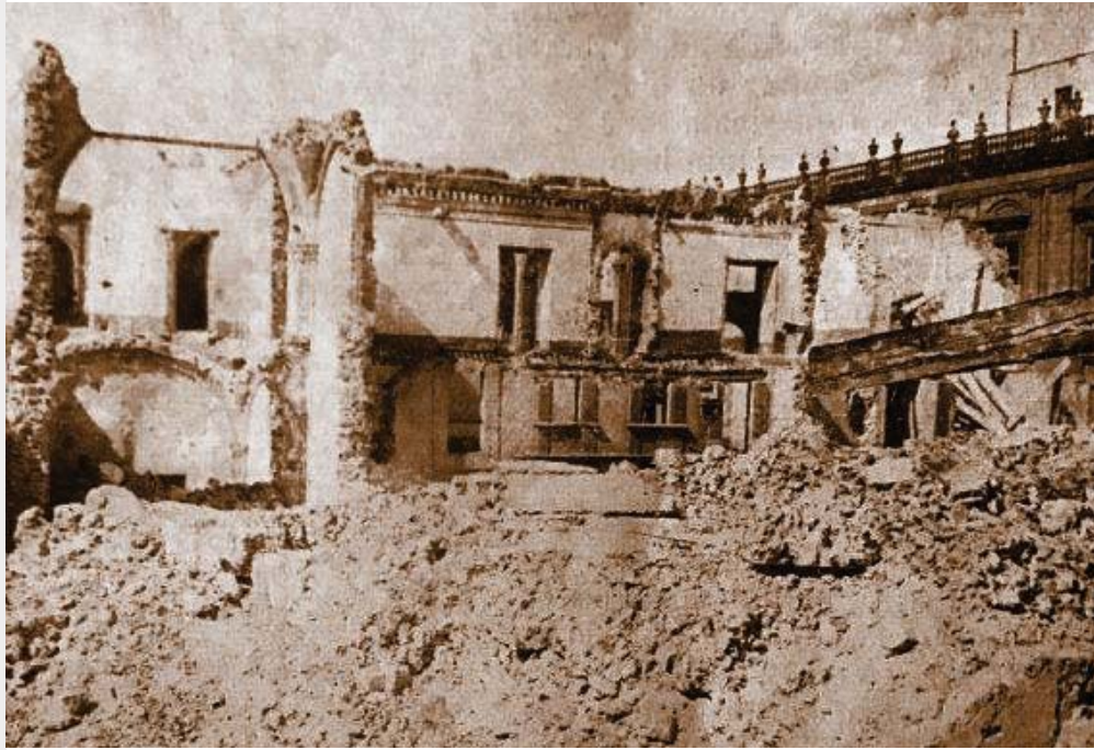
Gráfico 102. Demolición del antiguo Hospital de Terceros. Foto: Colección Villasana - Torres.
