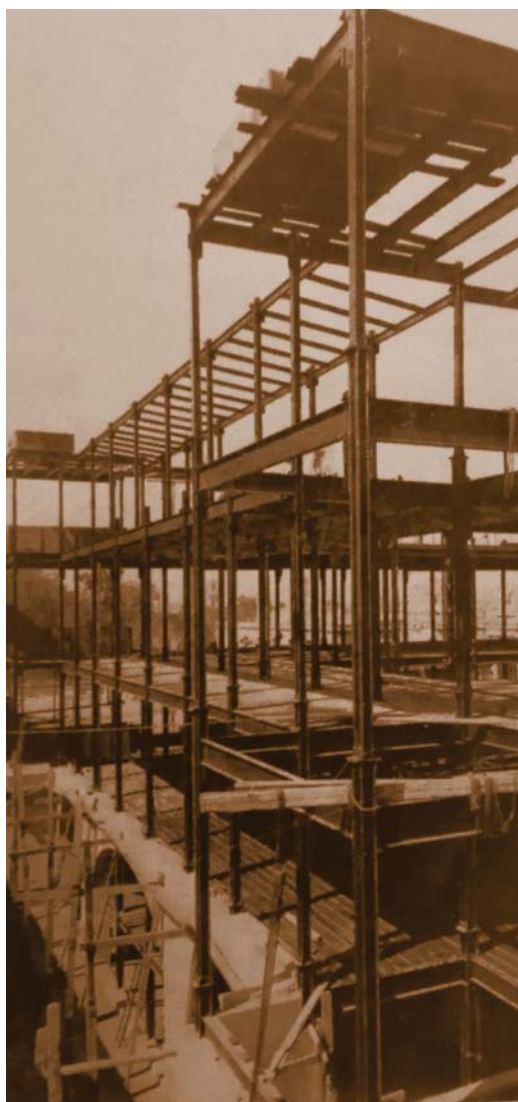
Gráfico 114. Una de las cuatro torres con estructura de acero (Schroeder, 1988).
