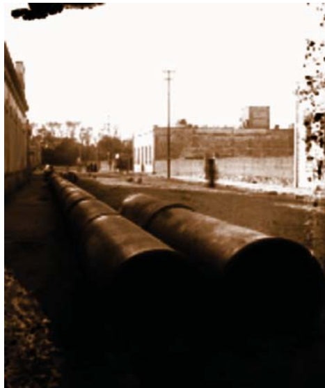
Gráfico 18. Tubos de drenaje en una calle. (Casasola, 1915).
