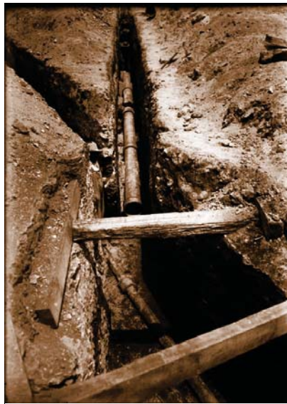
Gráfico 12. Tuberías para el drenaje. (Casasola, 1925).
