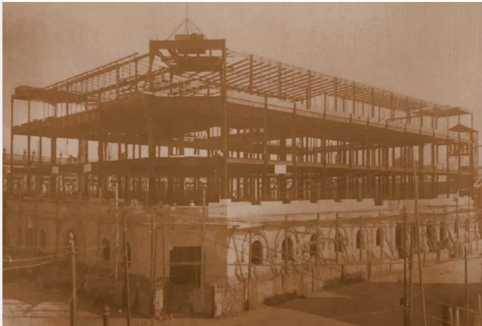
Gráfico 129. Postes y perfiles de acero (alma llena). (Schroeder, 1988).
