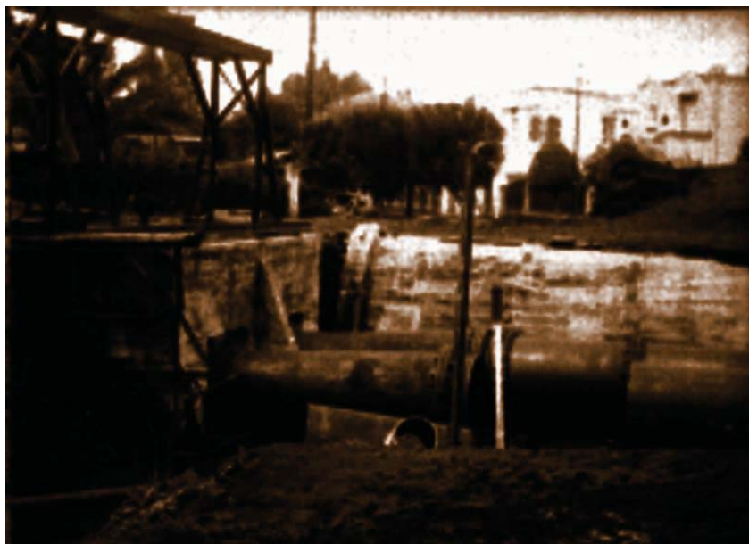
Gráfico 17. Introducción de tubos de concreto para drenaje. (Casasola, 1920).
