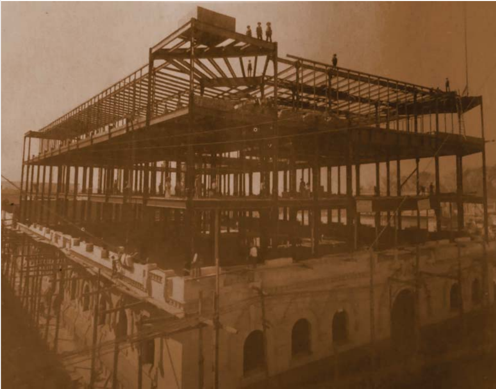
Gráfico 91. Revestimiento de piedra blanca de Pachuca (Schroeder, 1988).
