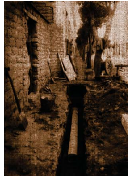
Gráfico 13. Introducción del drenaje en una calle. (Casasola, 1925).
