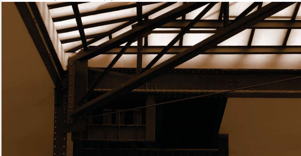
Gráfico 146. Armaduras de acero para el patio central. Foto: Jorge Vázquez.
