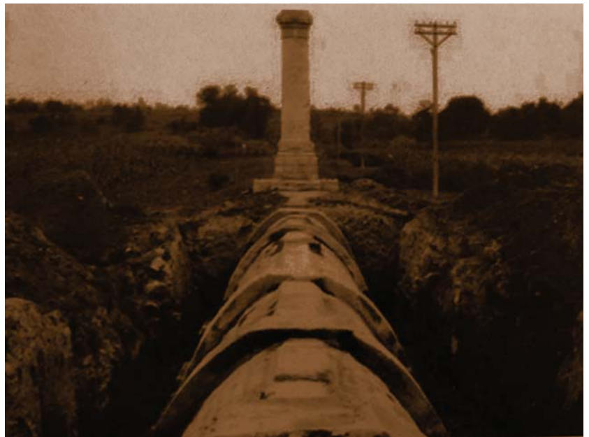
Gráfico 24. Vista del acueducto ovoide y un respiradero (Rolland, 2017).
