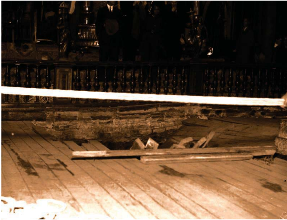
Gráfico 16. Hombres observan el hundimiento del piso de la Catedral. (Casasola, 1939).
