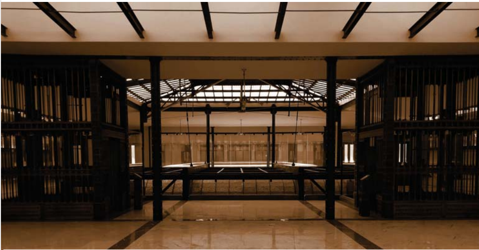
Gráfico 131. Esqueleto de acero de la Quinta Postal y los dos elevadores del acceso principal. Foto: Jorge Vázquez.
