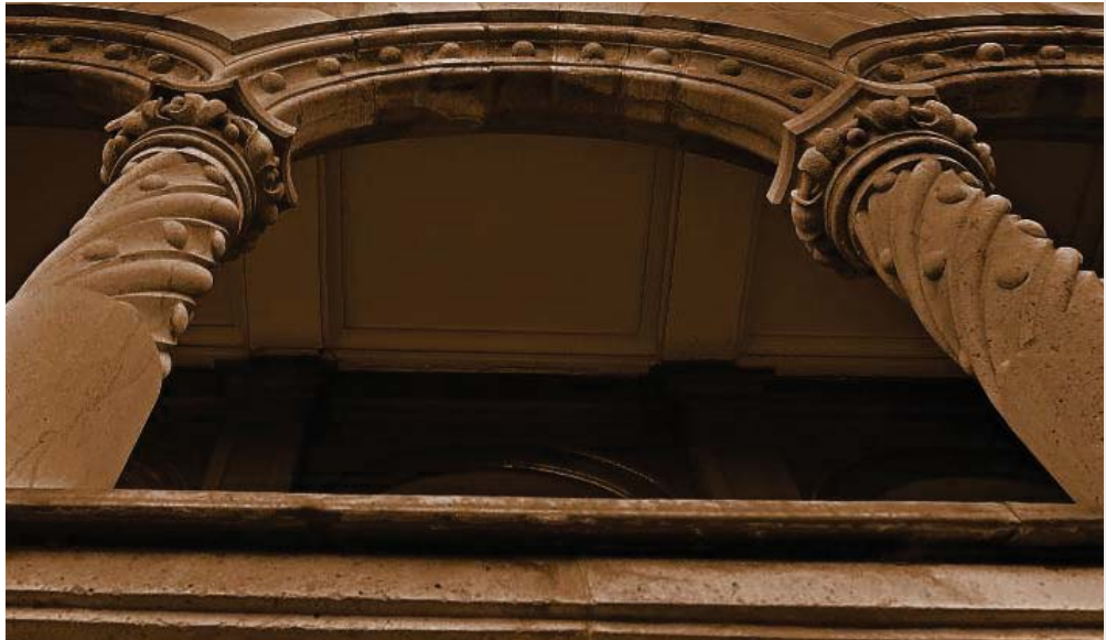
Gráfico 145. Columnas entorchadas o salomónicas y al fondo plafón de yeso del techo de la cubierta. Foto: Jorge Vázquez.
