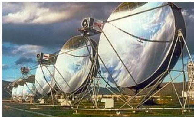
Ilustración 5.9 Sistema de Disco - Stirling
