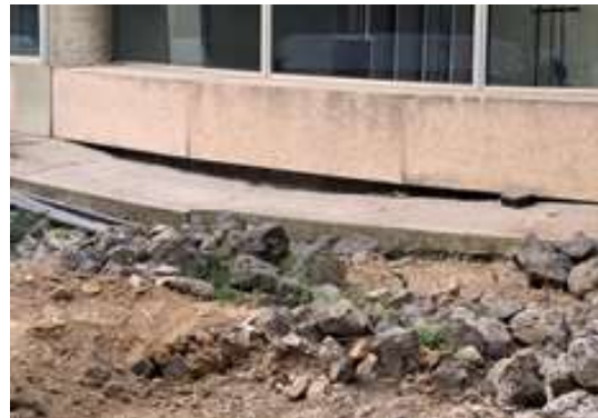
Ilustración 18. Contreras, Nayeli (2018).Trabajos de Nivelación [Fotografía] Fuente: propia
