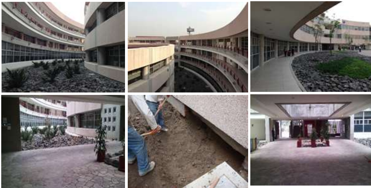
Ilustración 58. Grupo de Fotografías. Unidad de Posgrados UNAM. [FOTOGRAFÍA]. Fuente: Dirección General de Obras y Conservación UNAM. En el año 2019, cuando se empezó esta investigación los asentamientos irregulares ya eran notorios en zonas interiores y exteriores, específicamente en los edificios E, F, G y H.
