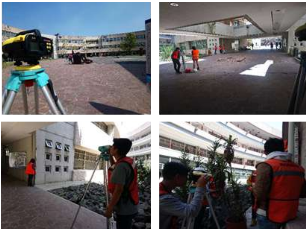
Ilustración 45, 46, 47, 48. Levantamiento Topográfico Edificio Unidad de Posgrados marzo 2019
