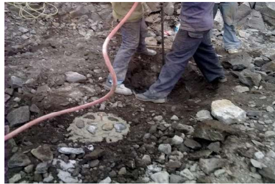
Ilustración 10 Contreras Nayeli (2018) Pozo a cielo abierto. Terreno de desplante Edificio Unidad de Posgrados UNAM [Fotografía]. Fuente: Dirección General de Obras y Conservación UNAM
