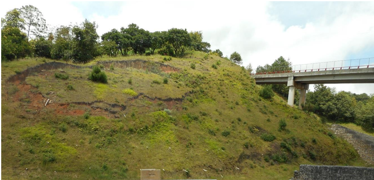
Figura III.1 Ejemplo de falla circular en un talud carretero (Dominguez, 2018).
