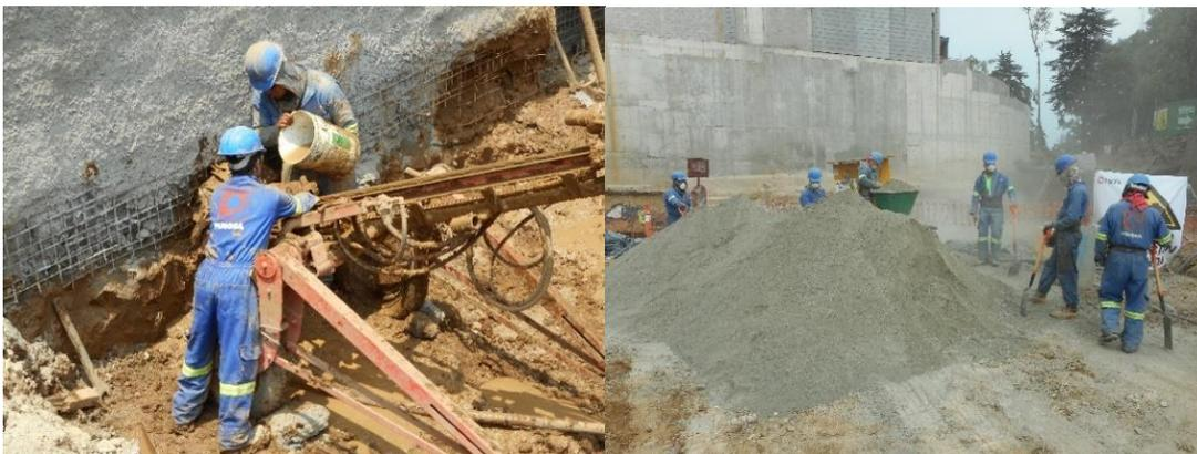
**Figura IV.2** múltiples deficiencias en el procedimiento constructivo que produjeron un comportamiento desfavorable en el sistema de contención.
