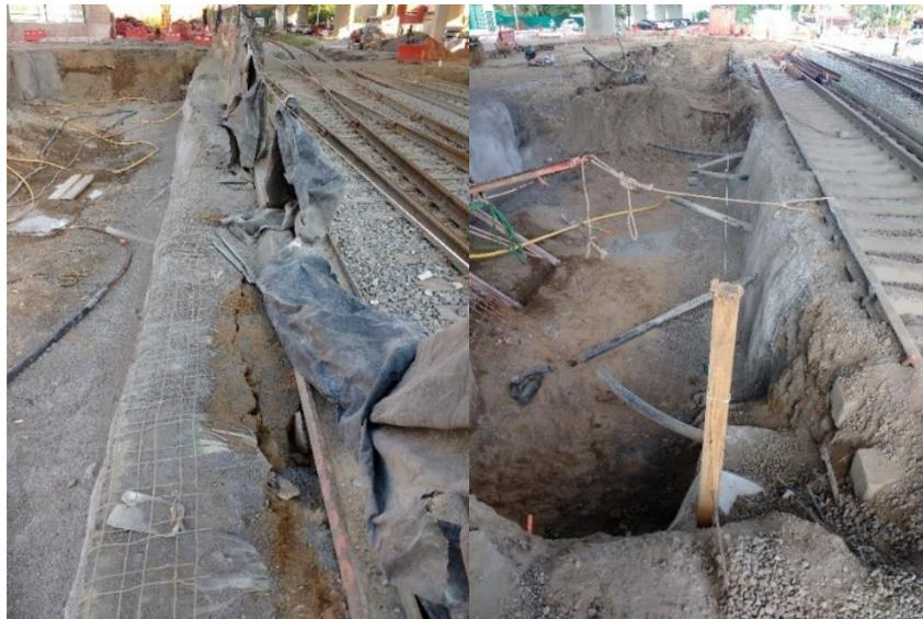
Figura IV.5 Grietas observadas en el suelo por detrás del muro de concreto lanzado, así como fallas locales en las paredes de la excavación que se extendieron hasta el trazo de los rieles.
