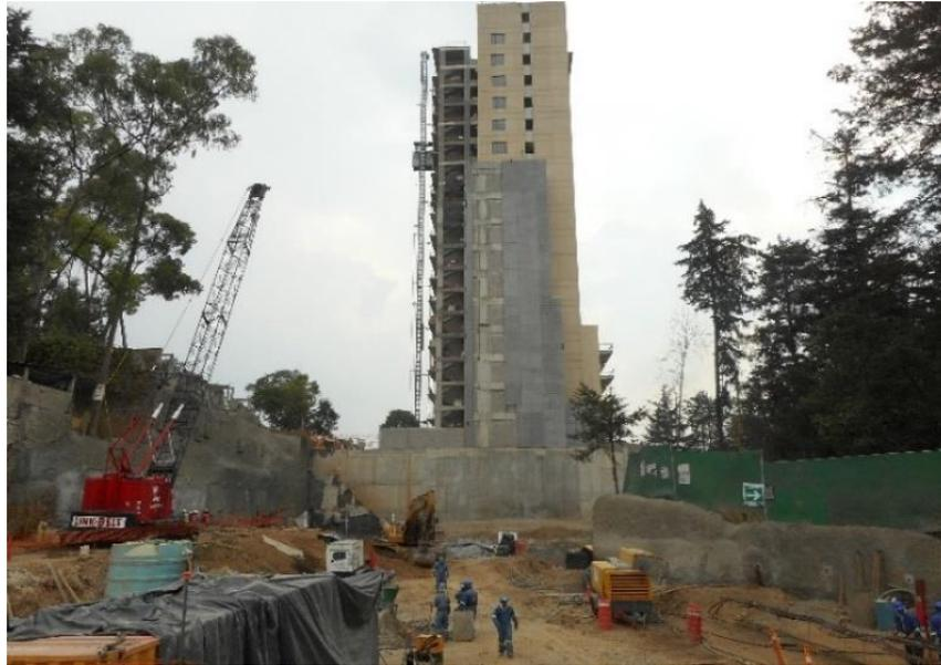
**Figura IV.1** Excavación profunda para un cajón complementado con pilas de cimentación en zona de lomas de la Ciudad de México.
