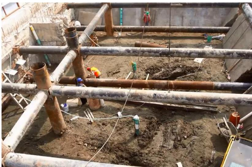
Figura V.4 Perfil intermedio para arriostramiento de troqueles (Paniagua, 2020).
