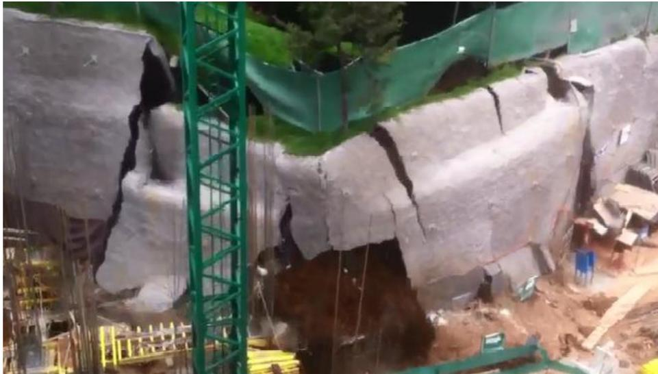
Figura IV.3 Vista frontal de la falla estructural del concreto lanzado complementado con anclas de tensión.
