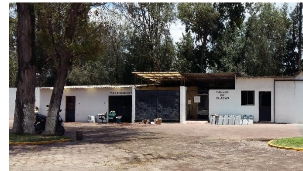
35. Mantenimiento, núcleo sanitario y taller de placas
