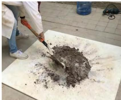
Figura 18.- Mezclado de los residuos y cementantes para el tabicón
