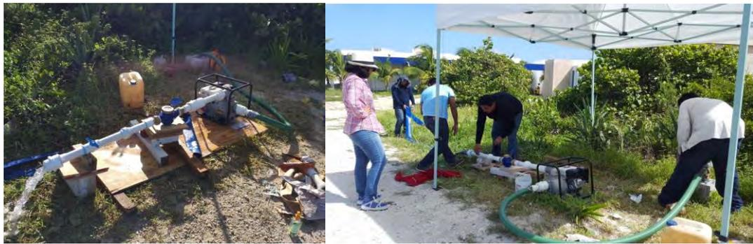
Figura 56. Sistema de extracción en prueba de aforo.
