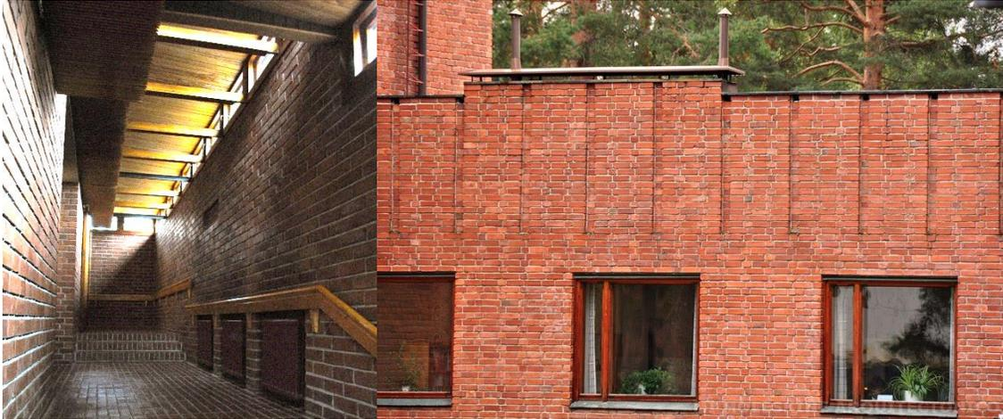
*Imagen. Uso de tabique recocido en interior y exterior.
