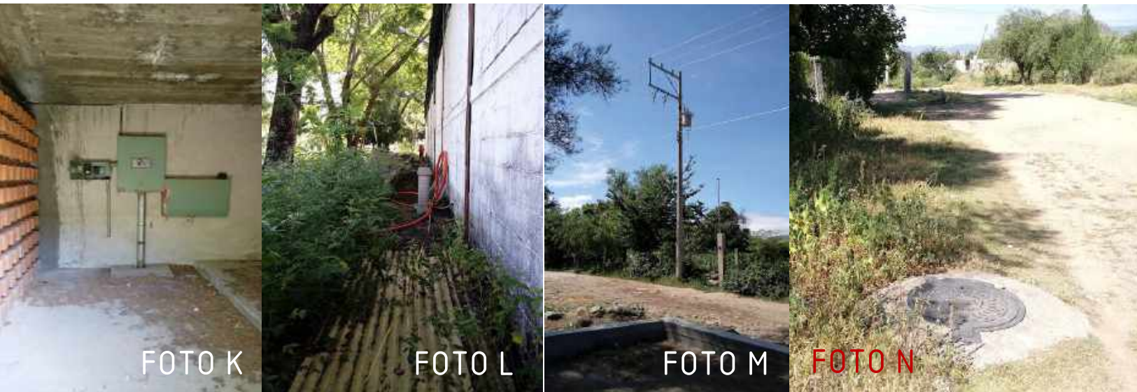
FOTO K. Se observan los tableros eléctricos que antes pertenecían a la fábrica. FOTO L. tubería que corresponde a la acometida hidráulica. FOTO M. Postes de CFE. FOTO N. Servicios de drenaje que se conectan directamente a la planta de tratamiento de aguas residuales de la población. FIGURA 54. Foto del terreno. Foto por: Lizbeth Gutiérrez Sosa.
