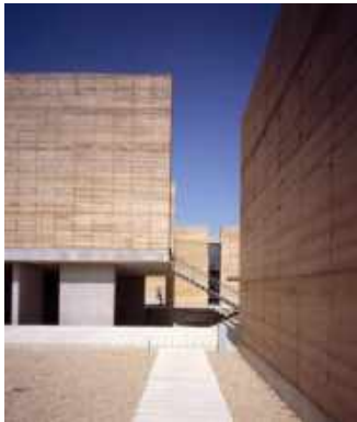
FIGURA 35. Fachada aparente de escuela. Foto por: Luis Gordo
