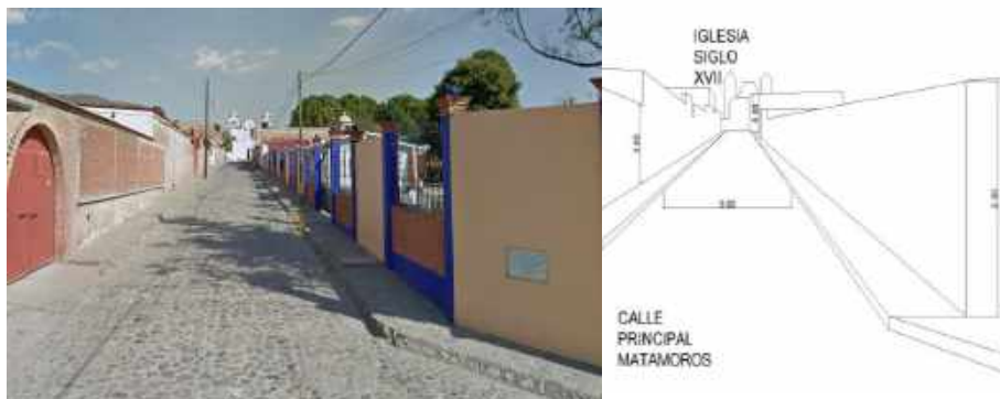
FIGURA 46. Calle Matamoros- se aprecia el empedrado y casas de ladrillo rojo recocido. Elaboración propia.
