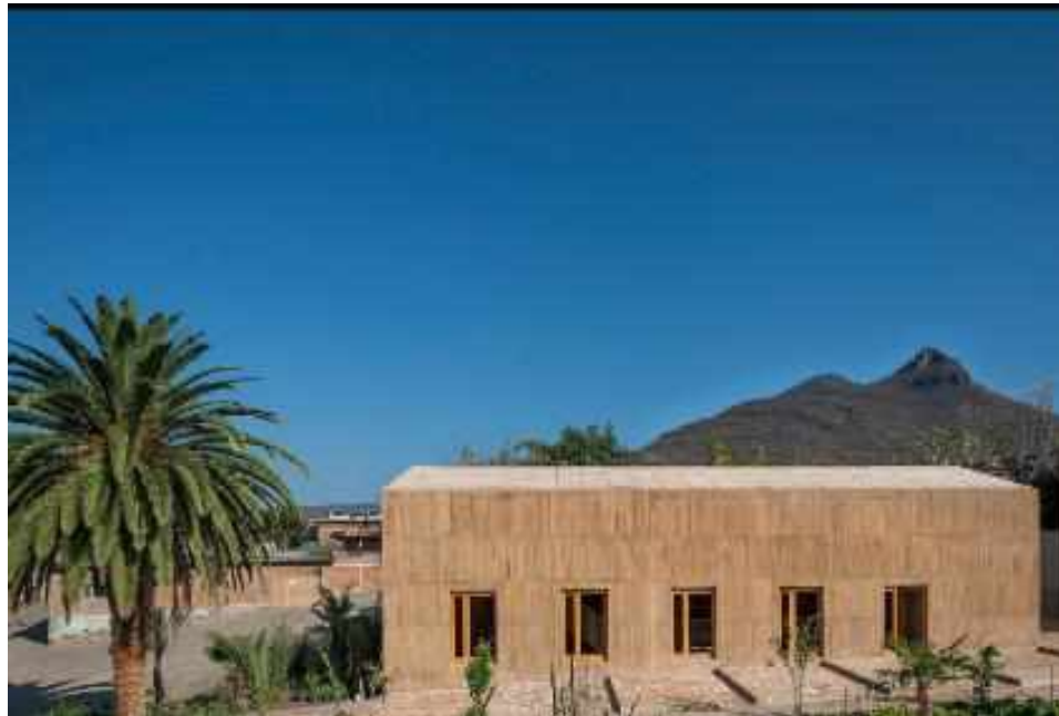
FIGURA 4. Centro cultural comunitario Teotitlán del valle/ productora. Edificio. 2017. Foto recuperada de página oficial productora 2019. http://productora-df.com.mx/project/centro-cultural-comunitario-teotitlan-del-valle/
