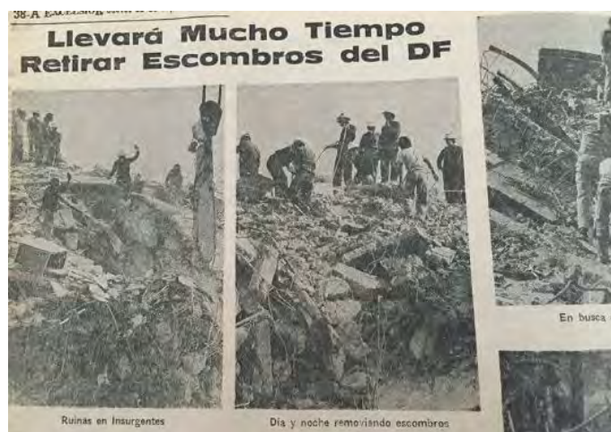
Figura 18. Escombros del sismo de 1985.
