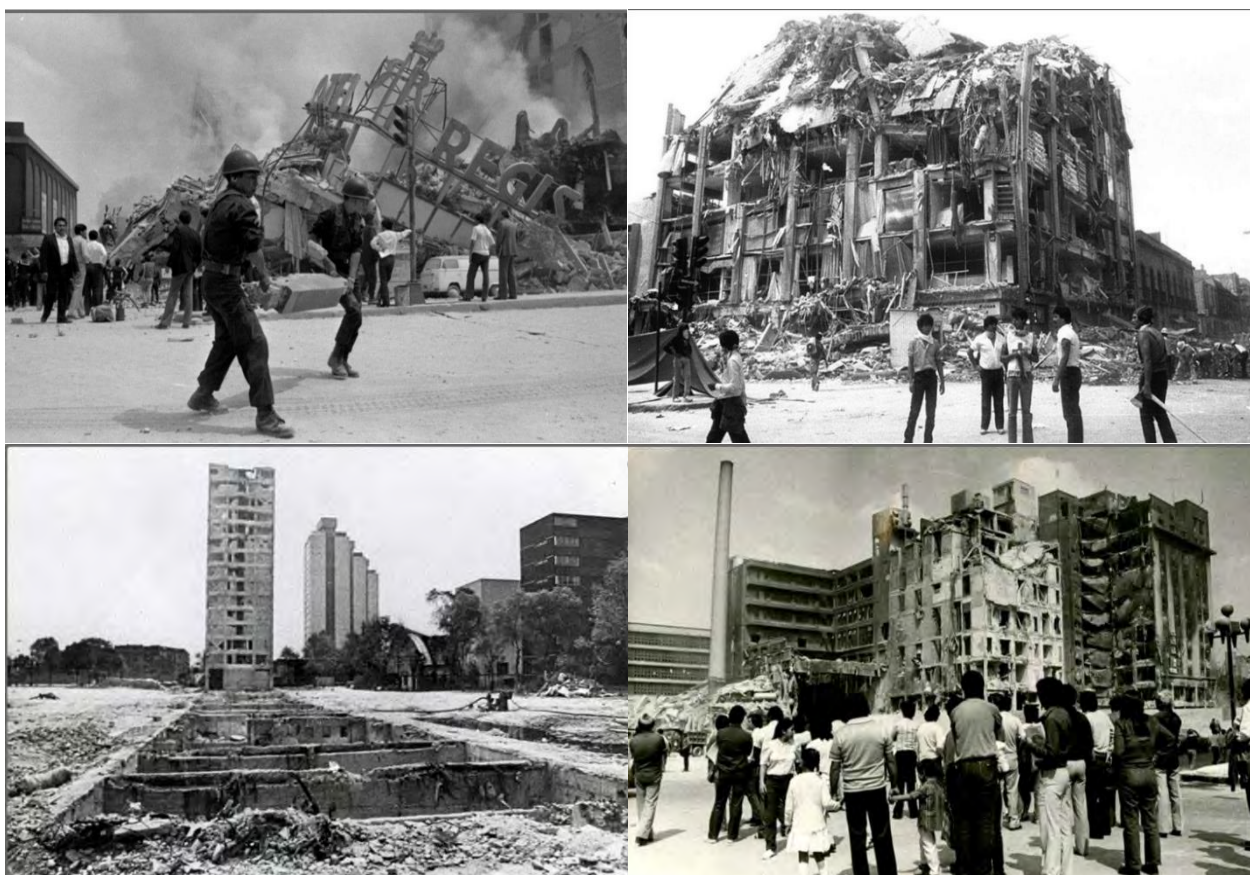
Figura 9. Daños ocasionados por los sismos de septiembre de 1985. Fuente: El Universal , 2019. https://interactivo.eluniversal.com.mx/sismo85-afectaciones/
