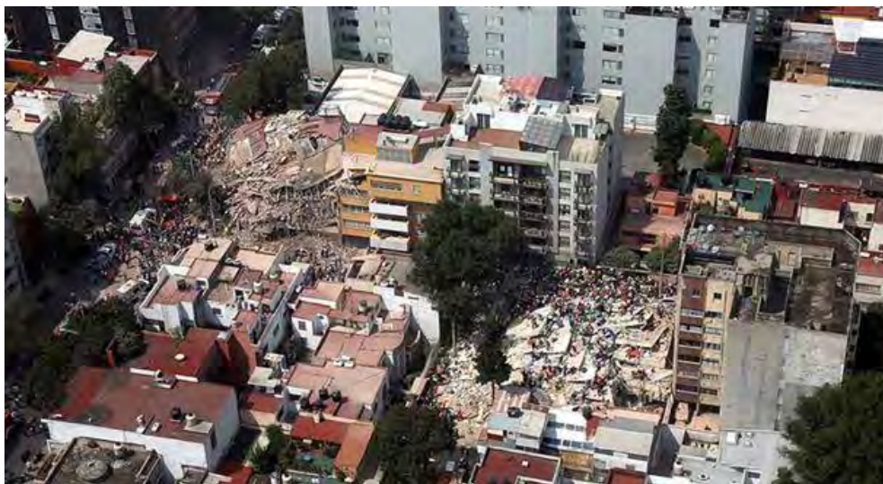
Figura 13. Daños ocasionados por los sismos de septiembre de 2017. Fuente: El Universal, 2017.
