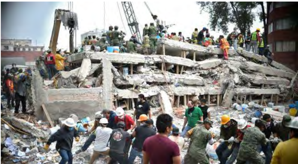
Figura 12. Daños ocasionados por el sismo del 19 de septiembre de 2017. Fuente: El Universal, 2017.
