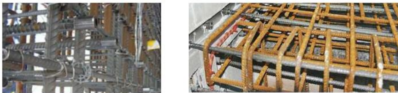
Fig. 57. Detalle de posicionamiento de conectores de varilla. Recuperado de: Ulma Construction.
