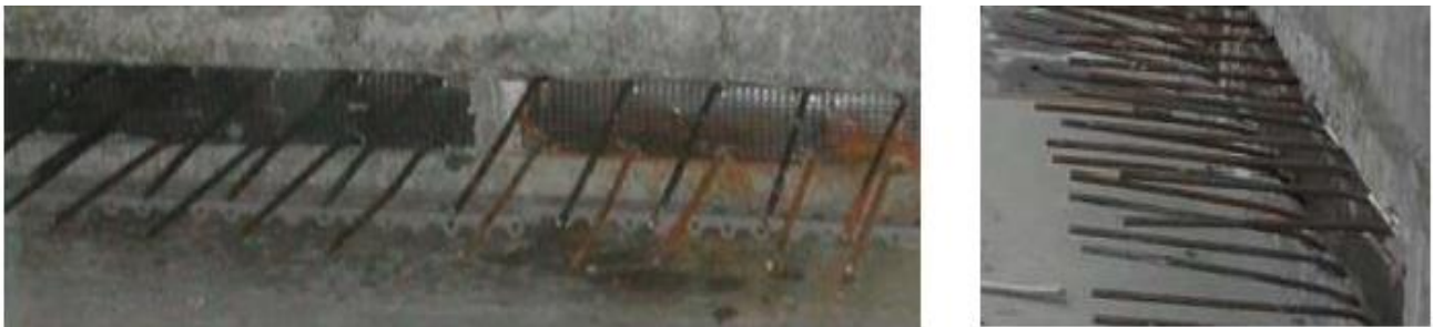
Fig. 56. Disposición de las varillas horizontales luego de volverlas a enderezar.
