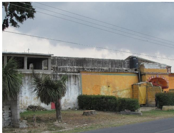
Figura 6. 62 Muro exterior y acceso principal alterados por la subdivisión del almacén en viviendas. 2018.
