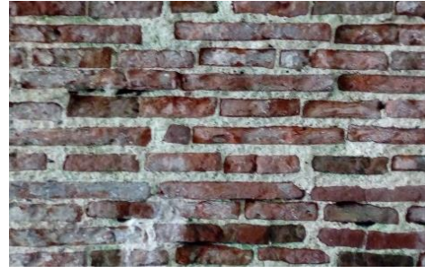
Figura 7. 48 Bóveda 3b. Aparejo combinando una hilada a tizón y otra hilada a soga.
