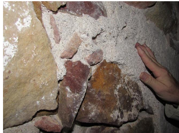
Figura 4. 10 Mampostería ordinaria irregular en el paramento interior de la muralla, Fortaleza de Montjuïc, Barcelona.
