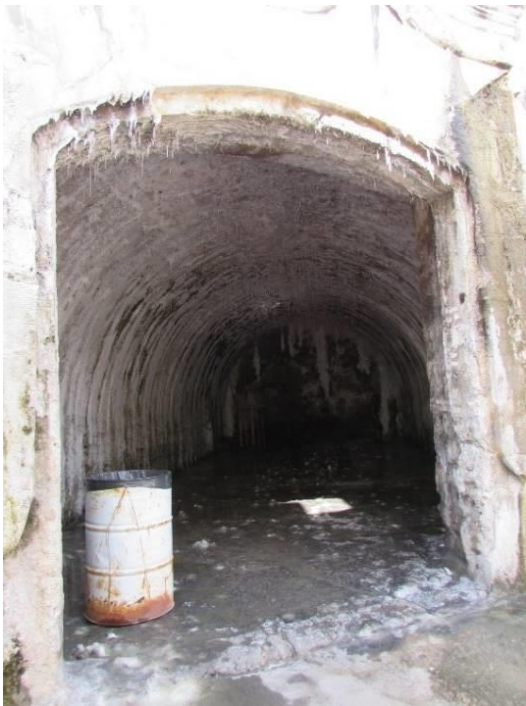
Figura 7. 52 Acceso a la bóveda B-04.
