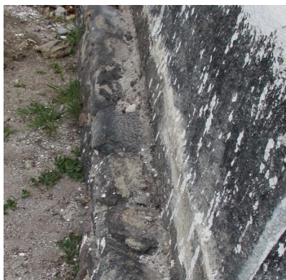
Figura 7. 68 Detalle del ancho de la cimentación de los edificios militares que sobre sale del paramento de muro de los edificios militares que inician con una hilada de bloques de piedra basáltica.
