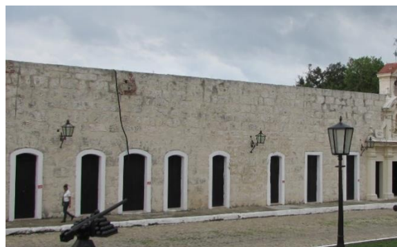
Figura 4. 28 Cerramientos con arcos escarzanos en puertas de fachada a plaza de armas en San Carlos de la Cabaña, La Habana.
