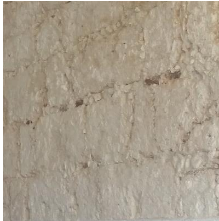
Figura 4. 24 Muros del interior de la iglesia en edificio militar, contruidos con sillares irregulares de cantería, colocados con ripios en juntas, además del uso de mortero de cal. Fortaleza de San Carlos de la Cabaña, La Habana.
