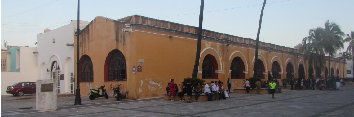
Figura 6. 47 Vista exterior de la única nave original del siglo XVIII que se conserva del edificio de las Atarazanas, 2019.
