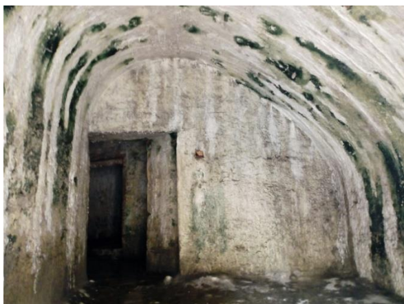
Figura 7. 57 Bóveda 5 con geometría de arco tranquil.
