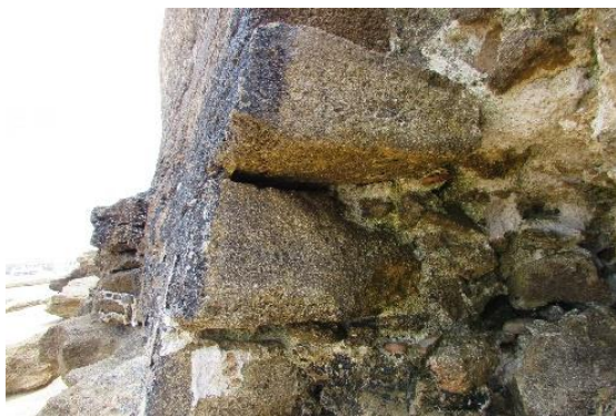
Figura 4. 15 Empotre de los sillares de piedra ostionera en la base de la muralla del Fuerte de San Sebastián, Cádiz. El corte del sillar parece prisma trapezoidal asentado sobre ripios y argamasa.
