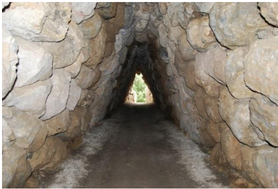
Figura 3. 4 Interior del tunel de Huttusa. Fuente: https://destinoinfinito.com/hattusa/
