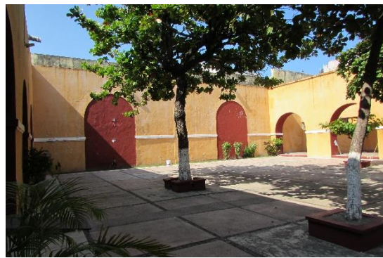
Figura 6. 49 Vista del patio interior del centro cultural que conserva en su muro el testimonio de la arcada de acceso de una de las naves de las Atarazanas. 2019
