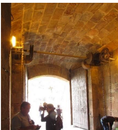
Figura 4. 31 Bóveda de arco rebajado conformado por sillares de cantería arenisca en aparejo isódomo en acceso a la Fortaleza de Montjuïc, Barcelona
