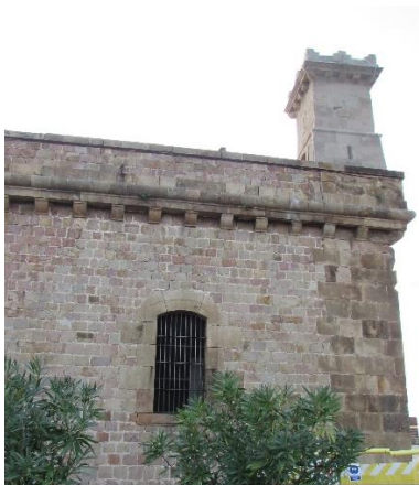
Figura 4. 17 sillares menores o sillarejos en edificio militar, colocados en aparejo isódomo regular juntoados con mezcla de cal arena.
