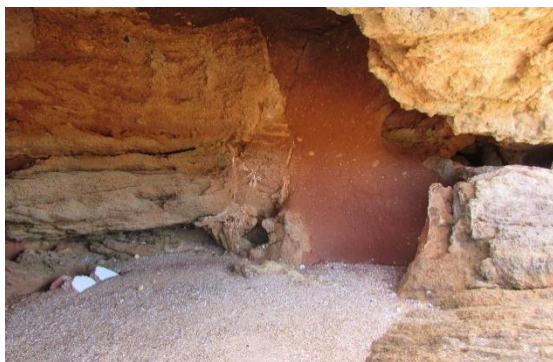
Figura 4. 16 A través de una oquedad en la muralla se pudo observar el relleno de arcilla rojiza del terraplén de la muralla en el Fuerte de San Sebastián en Cádiz. Nótese la diferencia del tono del relleno con la arena de mar acumulada en la parte inferior del muro.
