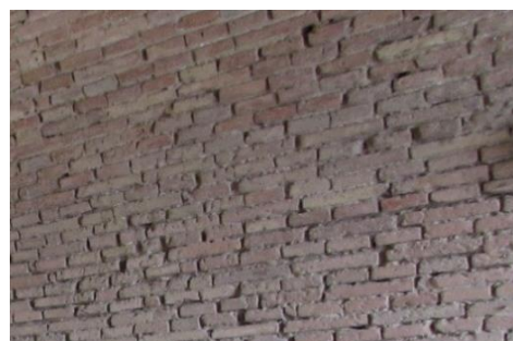
Figura 4. 35 Esta bóveda de la Fortaleza de Montjuïc, presenta un aparejo conocido como “inglés” por la combinación de una hilada a soga y una hilada a tizón.
