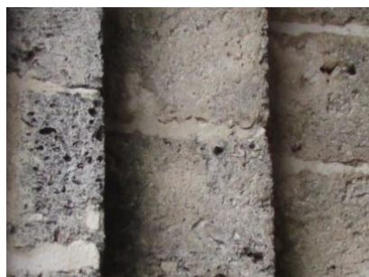
Figura 4. 7 Rocas sedimentarias de base calcarenitas en sillares, Fortaleza San Carlos de la Cabaña, La Habana (1763).
