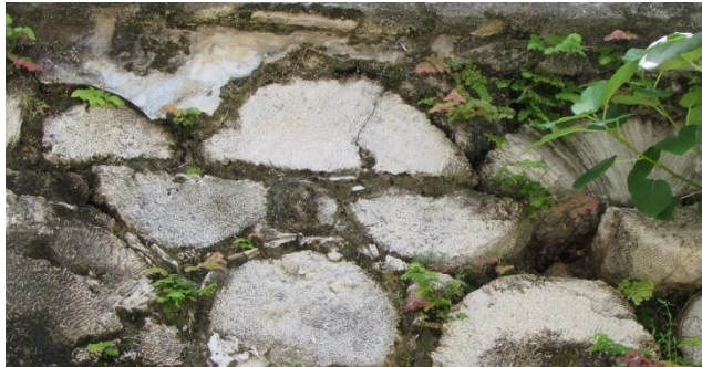
Figura 7. 18 Detalle de la disposición encontrada de los corales en el enrase de muros del revellín.
