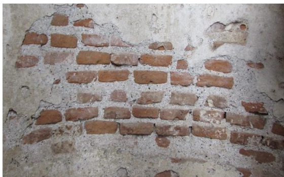
Figura 7. 77 Vista interior del muro de una garita
