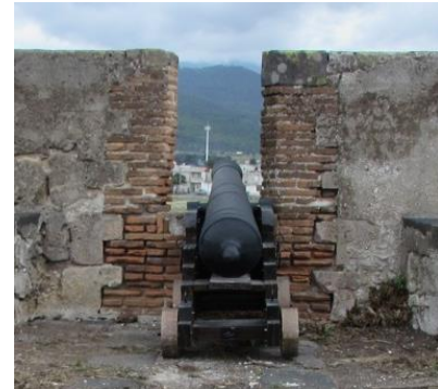
Figura 7. 79 Perfiles y boquillas de merlones y troneras con ladrillo
