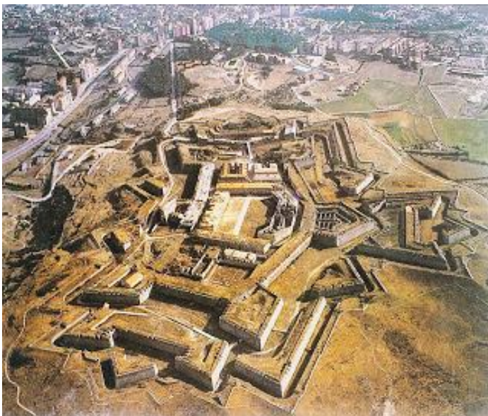
Figura 3. 12 Vista aérea de San Fernando de Figueras, obra representativa del máximo desarrollo de la arquitectura militar del siglo XVIII. Fuente de la imagen: https://bellumartishistoriamilitar.blogspot.com/2013/11/castillo-de-san-fernando-en-figueras.html
