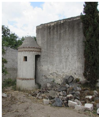
Figura 6. 60 Al pie de una de las garitas del almacén de pólvora 1, se observan restos de piedra labrada producto de algunos retiros en el elemento. 2018
