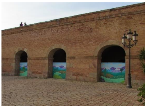
Figura 4. 27 Arcos elípticos 234 en fachadas de edificios militares a plaza de armas de la Fortaleza de Montjuïc.
