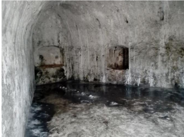
Figura 7. 63 Bóveda B-06 que remata en el muro con un arco elíptico peraltado.
