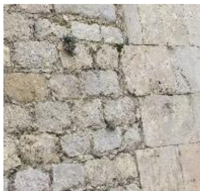
Figura 4. 5 Rocas graníticas en sillares y sillarejos en la Fortaleza de San Fernando de Figueras (1753).
