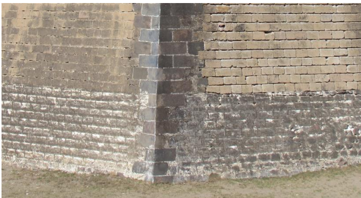
Figura 7. 65 Sillería labrada en piedra basáltica que forma parte de la cimentación de la muralla
