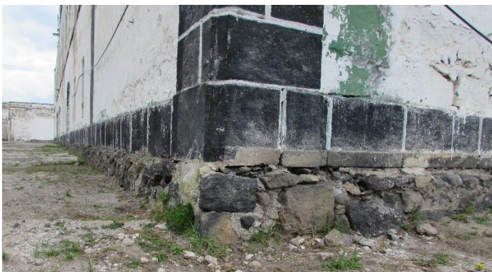
Figura 7. 67 Obras de mampostería ordinaria con piedra basáltica en la cimentación de los edificios militares
