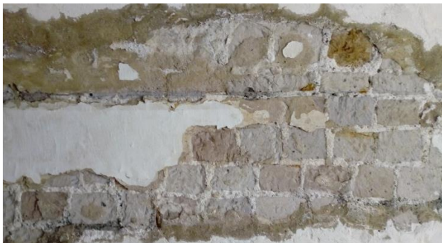
Figura 7. 82 Sillares de cantería en la bóveda B-01 que corresponde a una casamata, cabe destacar que la disposición de las piezas es a tizón.
