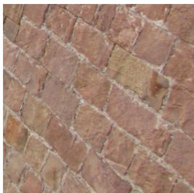
Figura 4. 4 Rocas sedimentarias areniscas en sillares, Fortaleza de Montjuïc, Barcelona (1751).
