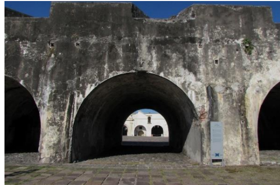
Figura 7. 44 Bóveda B-03 de la cortadura de San Fernando. 2018.
