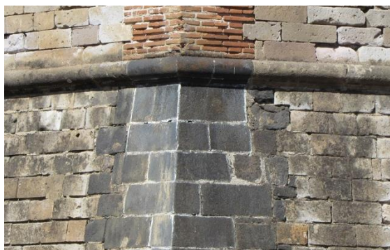
Figura 7. 78 Refuerzos en vértice de baluarte con sillares de piedra basáltica
