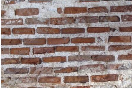
Figura 7. 47 Bóveda 3a. Aparejo a tizón en la parte superior del intradós.
