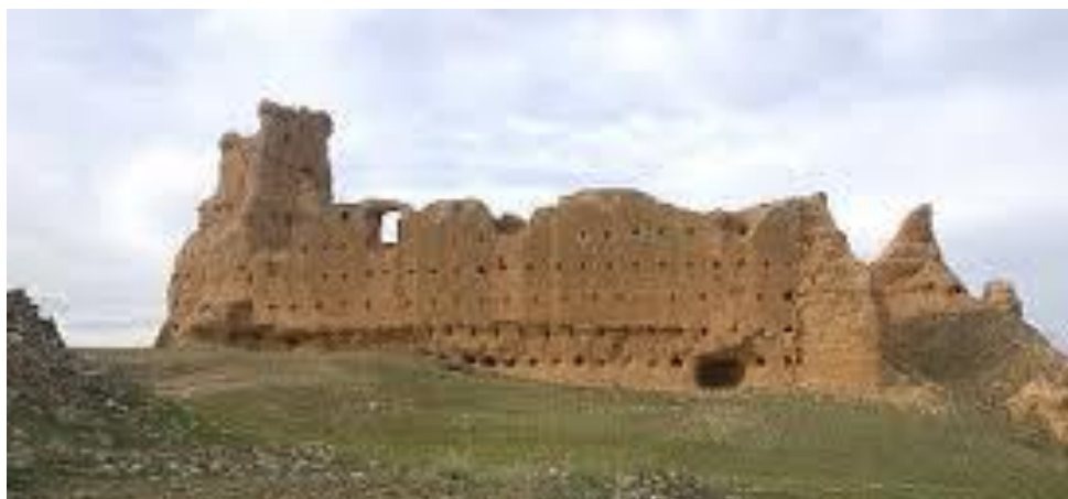
Figura 3. 9 muros de tapia de tierra en las ruinas del castillo de Serón en Soria, España. Fuente: https://listarojapatrimonio.org/ficha/castillo_de_seron_de_nagima
