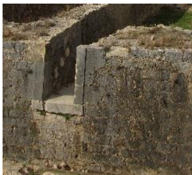
Figura 4. 21 Sillares semi regulares con disposición en isodomo en muros no concluidos del revellín de Santa Bárbara.
