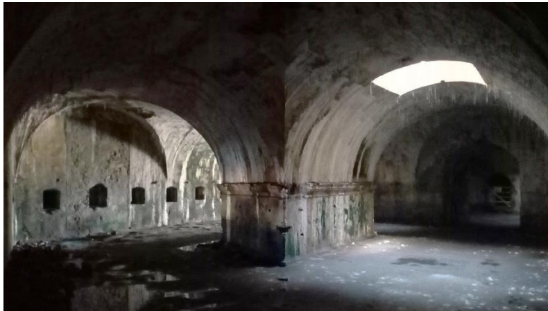
Figura 7. 33 Vista del apoyo central común a las ocho bóvedas que cubren la ampliación del semibaluarte de San Pedro.
