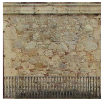
Figura 4. 22 Mampostería ordinaria irregular con algunas piezas de piedra careadas, en fachada a plaza de armas del Pabellón del Estado Mayor.
