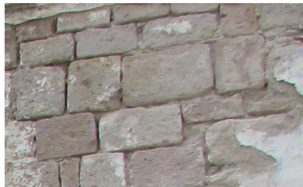
Figura 7. 70 Detalle del muro de fachada de casamatas sureste.
