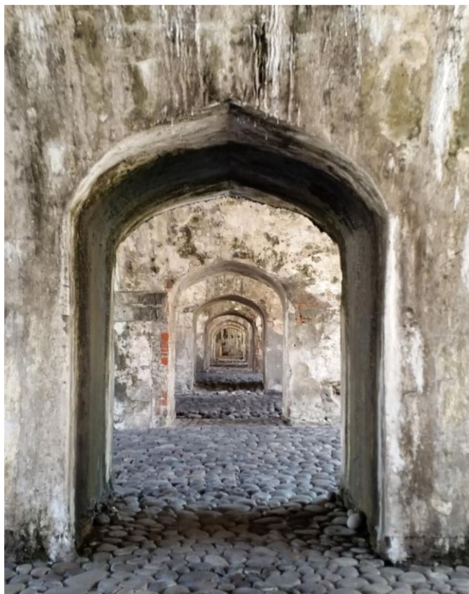
Figura 6. 17 Vista actual del interior de la cortadura de San Fernando en el Fuerte de San Juan de Ulúa.
