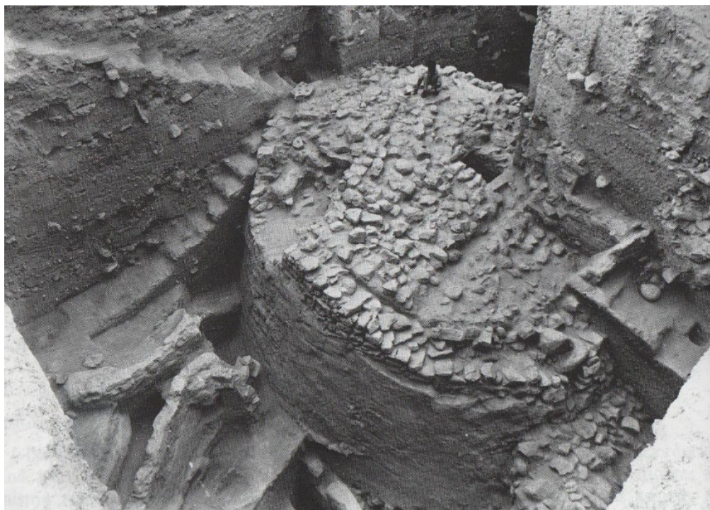
Figura 3. 2 Torre de la muralla de Jericó. Fuente: Kostof, Historia de la arquitectura, p. 86
