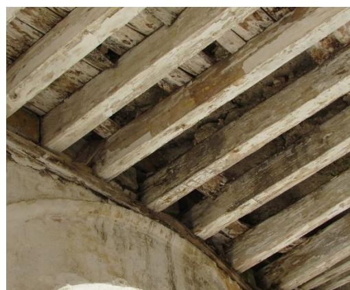
Figura 6. 56 Condiciones de la estructura de entrepiso en pasillos de edificios militares. 2019
