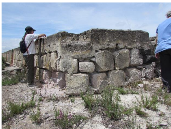
Figura 7. 75 Mampostería careada en los parapetos
