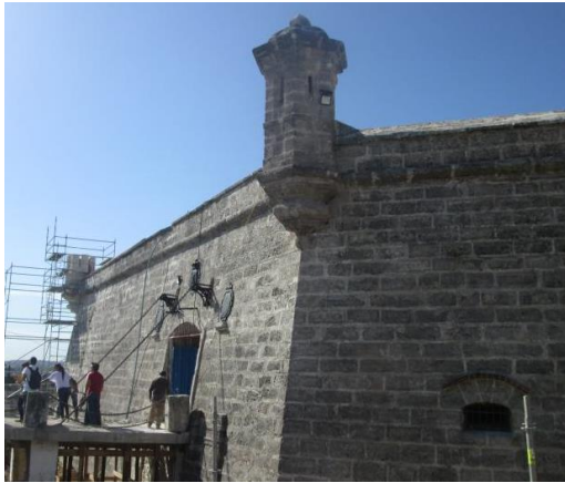
Figura 4. 8 Aparejo en isódomo con sillares regulares en el Fuerte de Santo Domingo Atarés, La Habana.
