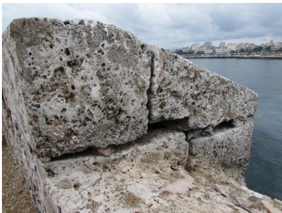
Figura 7. 2 Sillares labrados de roca caliza arrecifal que forman un parapeto en el Castillo de los Tres Reyes del Morro, La Habana, Cuba. 2018.
