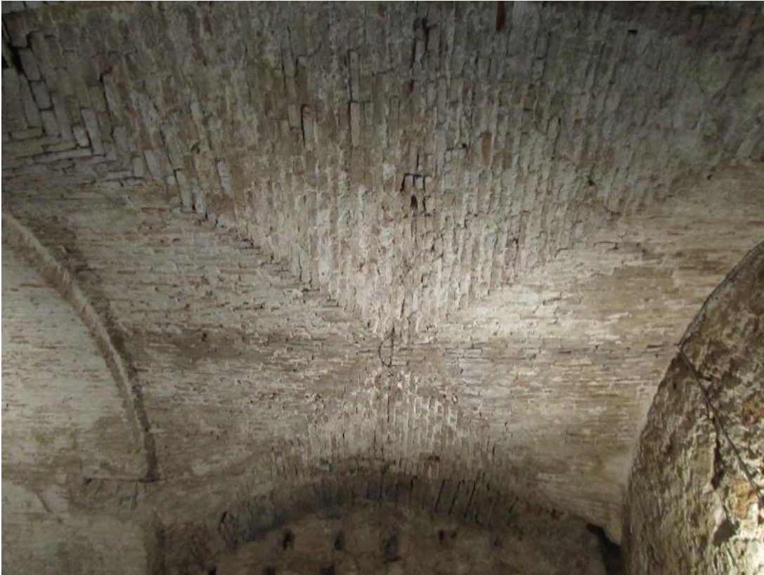
Figura 4. 36 Bóveda de arista con aparejo dispuesto una hilada a tizón y una hilada a soga. Además, en la arista es visible la composición de un aparejo en espiga. Cubierta de Caballerizas en San Fernando de Figueras.
