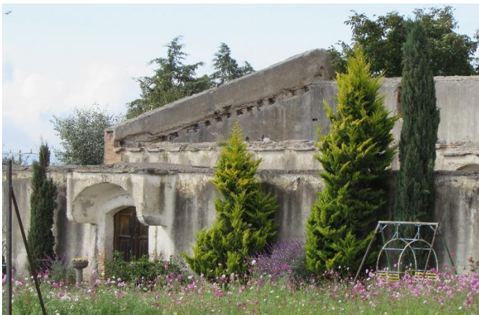
Figura 6. 59 Testimonio de la estructura de cubierta del almacén de pólvora 1 en la localidad de Francisco I Madero, Perote, 2019.
