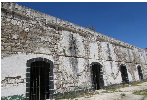
Figura 6. 55 Fachada interior de las cortinas con casamatas. 2019
