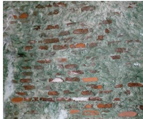
Figura 7. 54 Aparejo de la bóveda B-04.
