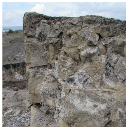
Figura 7. 76 Foto del corte de la piedra careada en los parapetos.
