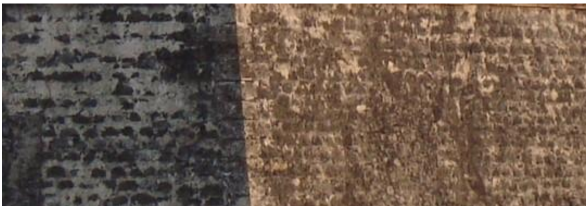
Figura 7. 14 Muros de coral semiesférico dispuestos en hiladas regulares y cuidando el cuatrapeo de las piezas. Además, se observa el refuerzo con sillares a modo de "rafas" en el vértice de los muros que une el flanco y cara del baluarte de San Pedro. 2018.
