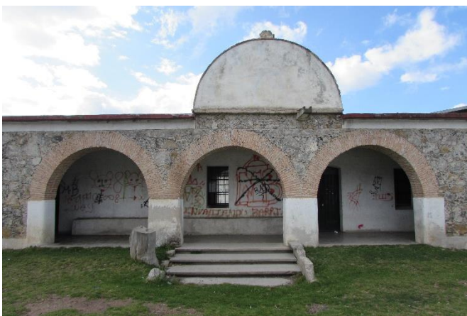
Figura 6. 57 Fachada principal del cuerpo de guardia ubicado en la localidad de Francisco I Madero, Perote. 2019.
