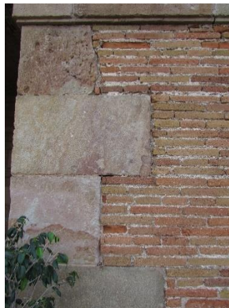
Figura 4. 18 Combinación de muros de ladrillo con tres hiladas a soga – una hilada a tizón, refuerzos en vanos de arcada con sillares de cantería en fachadas a plaza de armas.
