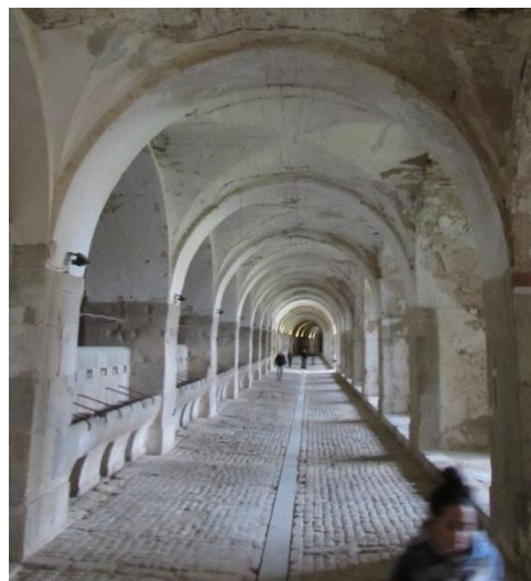
Figura 4. 26 Bóveda de arista en las caballerizas de San Fernando de Figueras.
