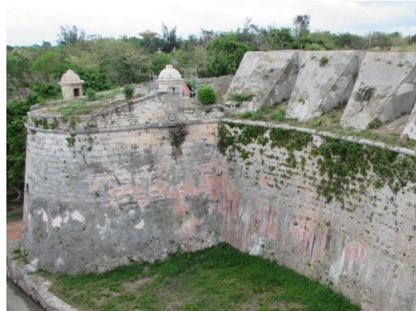
Figura 4. 9 Sillares en aparejo isódomo en la muralla de la Fortaleza de San Carlos de la Cabaña, La Habana.
