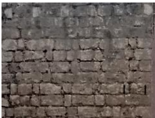
Figura 4. 23 Aparejo aparentemente diatónico en muros de edificios militares a plaza de armas o calle militar de la Fortaleza de San Carlos de la Cabaña, La Habana.
