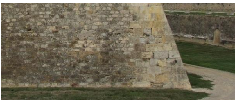
Figura 4. 11 Detalle de la parte inferior del paramento del hornabeque de San Roque, en la Fortaleza de San Fernando de Figueras, en donde se aprecia el uso de sillares grandes sólo en los vértices o ángulos.
