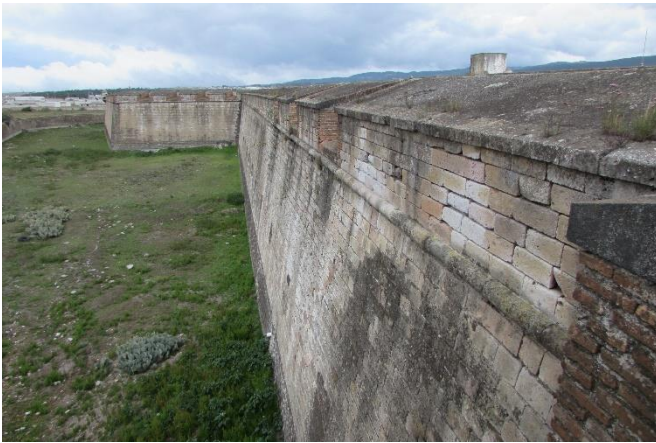
Figura 6. 53 Muralla y parapeto del Forte de San Carlos. 2019.
