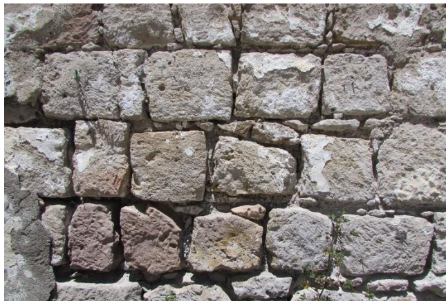
Figura 7. 71 Detalle de la cantería semi escuadrada en hiladas en muro de fachada de casamatas noreste.
