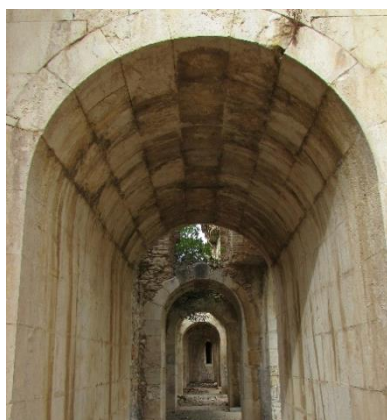
Figura 4. 32 Bóvedas con sillares regulares labrados como dovelas dispuestas en aparejo isódomo en pabellones de plaza de armas. Fortaleza San Fernando de Figueras.
