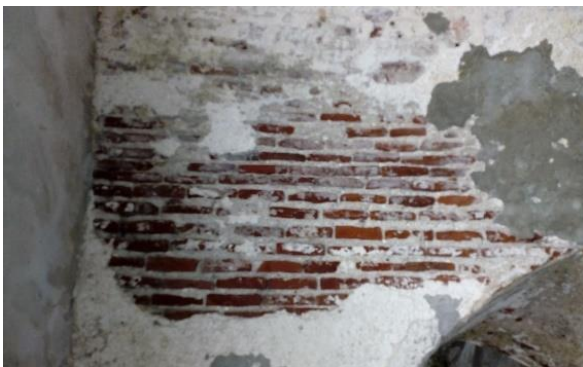
Figura 7. 29 Imágenes del aparejo identificado en la B-01 y su registro gráfico en sitio
