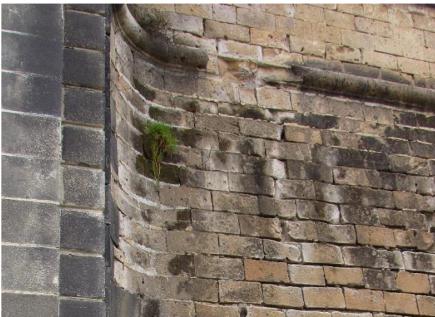
Figura 7. 5 Sillares de cantería de basalto negro en portada y sillares de cantería rosa en muro de cortina del Fuerte de San Carlos de Perote. 2017.
