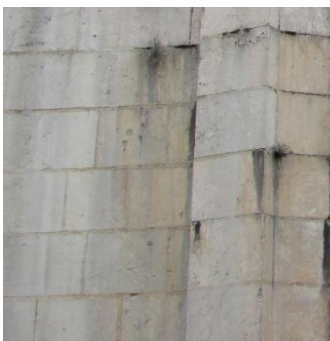
Figura 4. 20 Sillares regulares de cantería granítica en muros de la iglesia inacabada.
