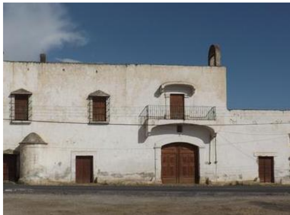
Figura 5. Acceso a la Casa Principal de la Hacienda de San Antonio Limón en la localidad de Totalco, municipio de Perote
