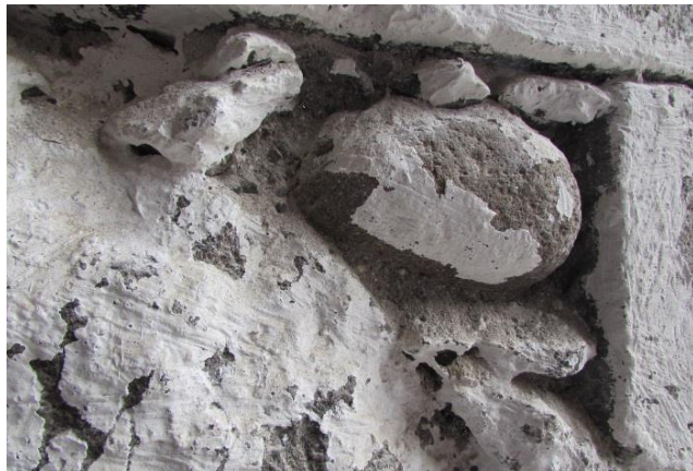
Figura 7. 74 Detalle de las obras de mampostería mixta encontradas como parte de algunos muros de los edificios militares
