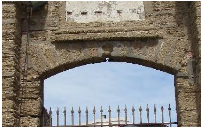
Figura 4. 29 Detalle del acceso principal al Castillo de San Sebastián en Cádiz, en donde se observa la composición del arco escarzano con dovelas labradas en piedra ostionera.
