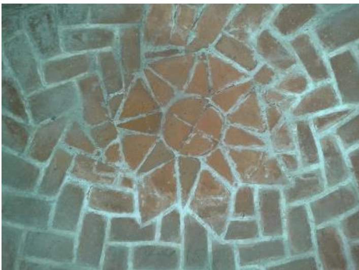
Figura 7. 9 Ladrillo en el intradós del cupulín de una garita del Fuerte de San Carlos de Perote. 2017.
