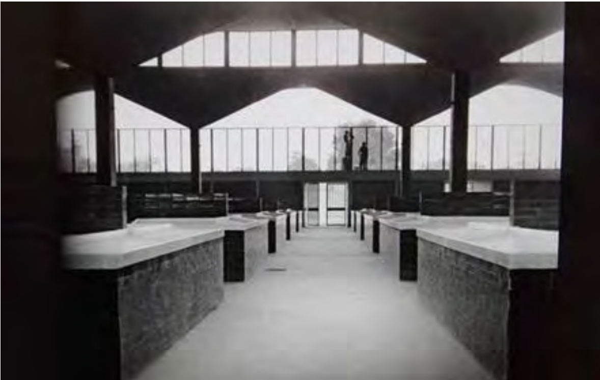
Fig. 3.18. Vista del interior, previo a su inauguración.
