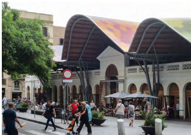
Derecha: Fig. 3.9. Vista exterior de la fachada principal.
