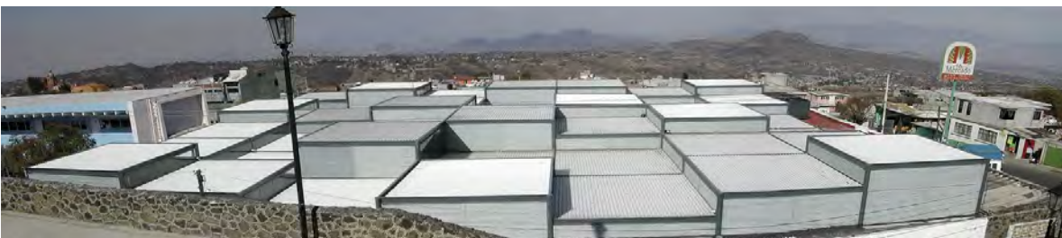
Fig. 3.1. Panorámica de las cubiertas del mercado. Fotografía obtenida de: http://www.redfundamentos.com/blog/e/obras/detalle-119/
