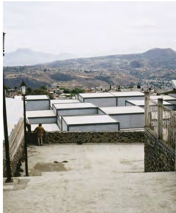
Fig. 3.7. Vista del mercado en su entorno. Fotografía obtenida de: http://www.redfundamentos.com/blog/e/obras/detalle-119/
