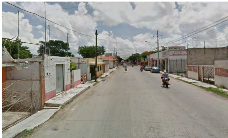
Fig. 2.22. Vista de la Colonia Dolores Otero desde la Avenida Circuito Colonias. Imagen tomada de Google Earth.
