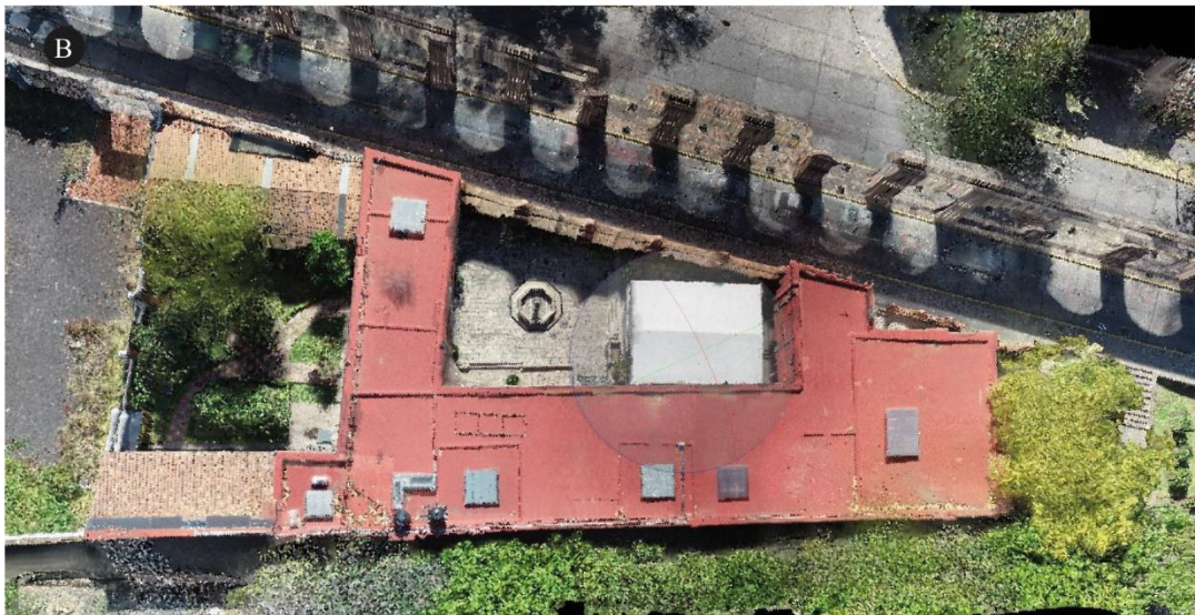
Figura 51 Modelos 3D realizados a partir de imágenes DRON y procesamiento de imágenes. A) Triangulación realizadas a partir de fotos referenciadas del edificio en planta. B) Modelo en 3D procesado del edificio en planta con una textura específica.
