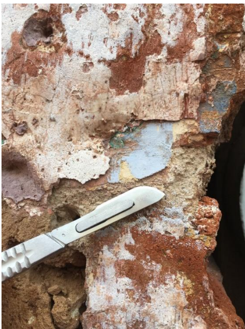
Imagen 81. Cala estratigráfica realizada en inmueble del siglo XIX-XX por restauradoras de bienes muebles en trabajo conjunto con arquitectos del grupo Al Centro Atotonilco . Fuente: Jaime de Alba Jaime.
