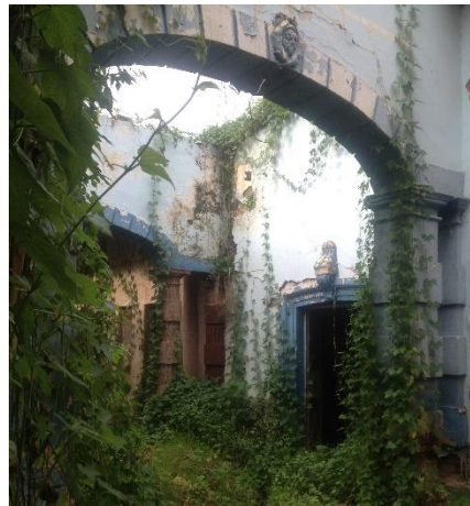
Imagen 75. Interior de imagen 5. Calle 20 de noviembre, Atotonilco el Alto. Fuente: Diana FS 2015.
