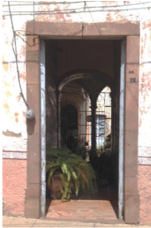
Imagen 45. Acceso principal a vivienda del siglo XIX en Atotonilco el Alto. Cerramiento con junta en el centro del vano. Fuente: Diana FS 2015.
