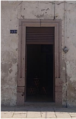
Imagen 44. Cerramiento con junta al centro en San Miguel el Alto. Fuente: Diana FS 2015.
