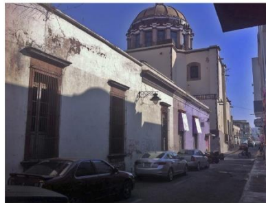
Foto 2- Fachada lateral sur.
