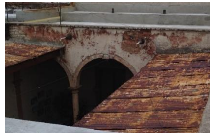
Imagen 53. Cubierta de lámina de zinc en corredores laterales. Casa en Morelos 78. Atotonilco el Alto, Jal. Fuente: Diana FS 2014.
