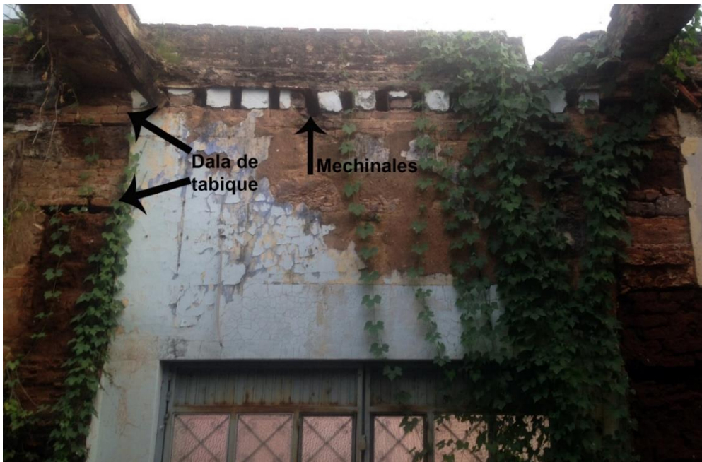
Imagen 43. Pérdida de cubierta, se distinguen los mechinales (huecos donde van colocadas las vigas) sobre dala de tabique, y el muro de adobe con vegetación parásita y alteración de vano. Vivienda del siglo XIX. Atotonilco el Alto. Fuente: Diana FS 2016.
