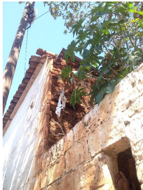
Imagen 34. Muro de adobe con recubrimiento de ladrillo rojo recocado. Fuente: Diana FS 2016.
