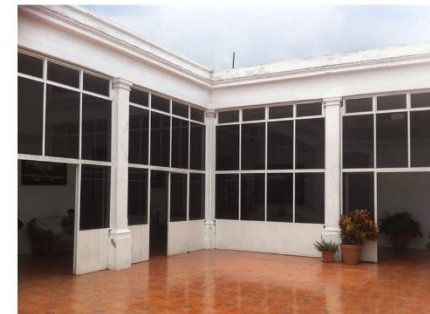
Foto 5- Vista de corredores laterales desde patio principal.
