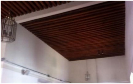
Imagen 51. Cubierta de vigería de madera y tablado. Casa en 5 de febrero 19. Atotonilco el Alto, Jal. Fuente: Diana FS 2014.
