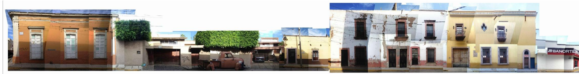
Imagen Estado Actual Calle Morelos 2 | Lado A
