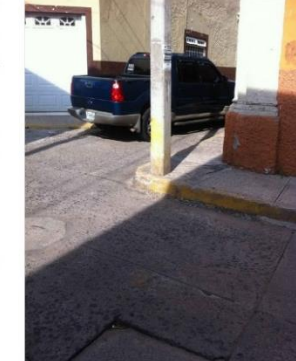
F14- Fotografía 14. Poste de cemento invadiendo paso peatonal
