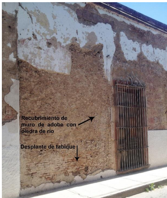
Imagen 33. Desplante de muro de tabique rojo recocado, muro de adobe con recubrimiento de piedra de río. Fuente: Diana FS 2017.
