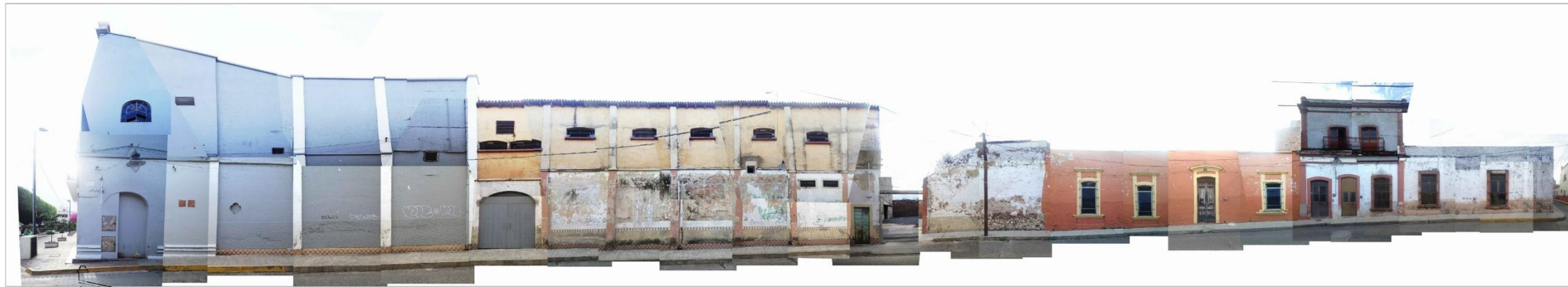
Calle Morelos 2 | Lado B Imagen Estado Actual
