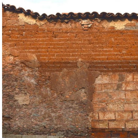
Imagen 38. Muro de adobe con recubrimiento de piedra de río y ladrillo rojo recocado en vivienda del siglo XX. Atotonilco el Alto. Fuente: Al Centro Atotonilco.
