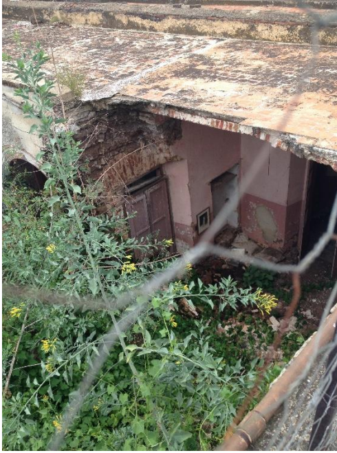
Imagen 41. Muro de adobe con platabanda de tabique rojo recocido. Cubierta de viga y bóveda de tabique. Fuente: Diana FS 2015.
