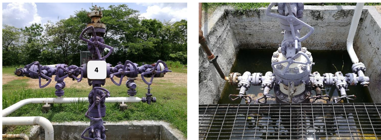
Figura 5.2.4 Instalaciones superficiales y condición actual del Pozo-4 (Elaboración propia).
