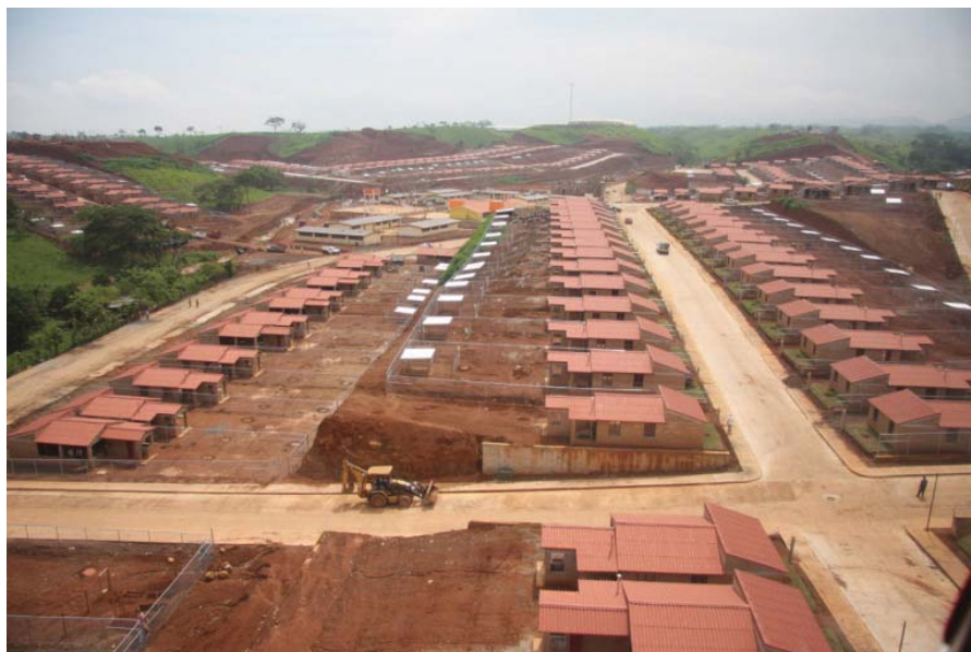
Inicio de la construcción del conjunto el Rehilete. www.mexyca.com
