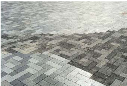
Pavimentos en Groningen, Holanda. https://www.karresenbrands.nl/_projects_en.php?id=88
