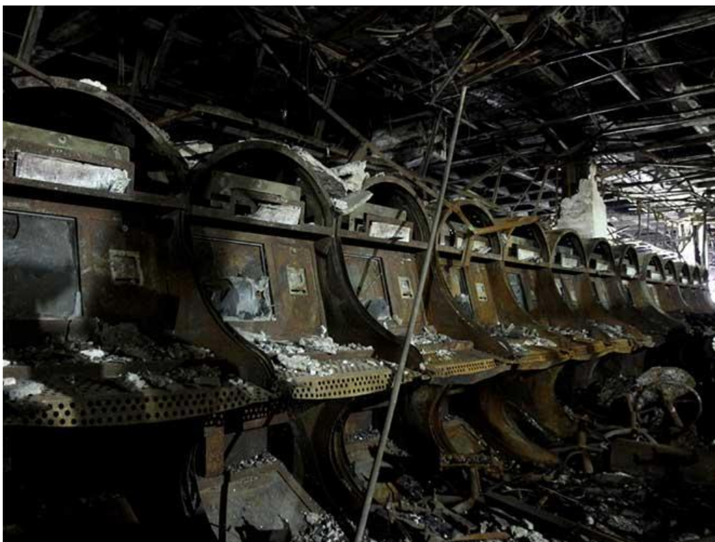
Máquinas del casino quemadas. Fuente: Posta. 312
