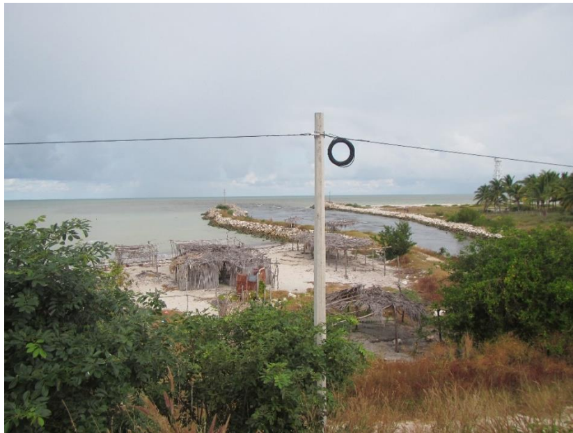
Figura 38. Escolleras en la boca del estero Sabancuy, donde se observan postes de comunicación y obras de recreación.
