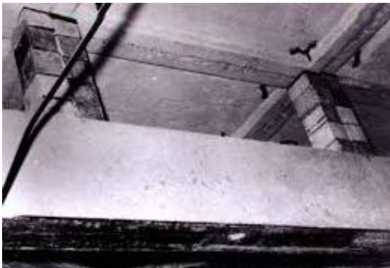
IMAGEN 87. LOSAS MÓVILES DE LA PLANTA BAJA. (ZEEVWOLFF, 2016)
