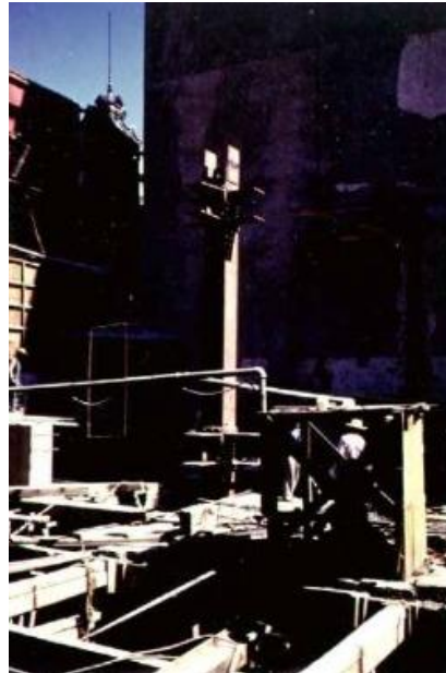
IMAGEN 90. COLOCACIÓN DE LAS COLUMNAS. (ZEEVWOLFF, 2016)
