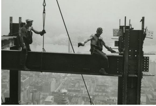
IMAGEN 43. MONTAJE DE LA ESTRUCTURA. (PFENNIGER, S/F)
