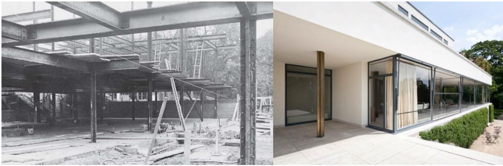
IMAGEN 37. CASA TUGENDHAT, ESTRUCTURA Y FACHADA (SE OBSERVA EL USO DE MUROS CORTINA). (CASTELLANOS, 2016)
