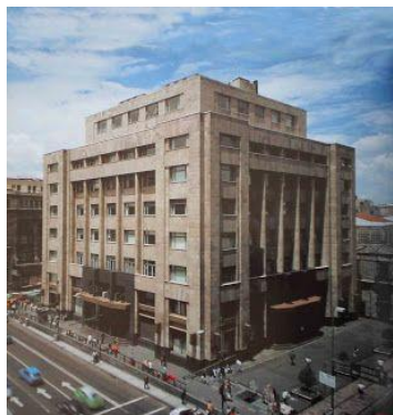
IMAGEN 30. EDIFICIO GUARDIOLA. (FIERRO, 2013)
