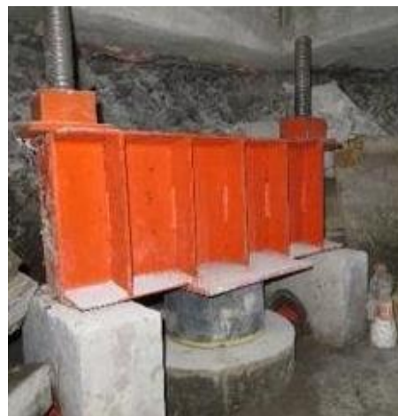
IMAGEN 49. PILOTES DE CONTROL. (SMIG, 2017)
