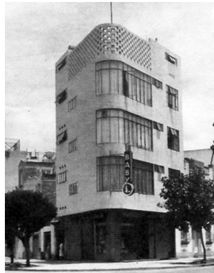
IMAGEN 46. EDIFICIO DE APARTAMENTOS EN AV. INSURGENTES 411. (LEAL, 2019)
