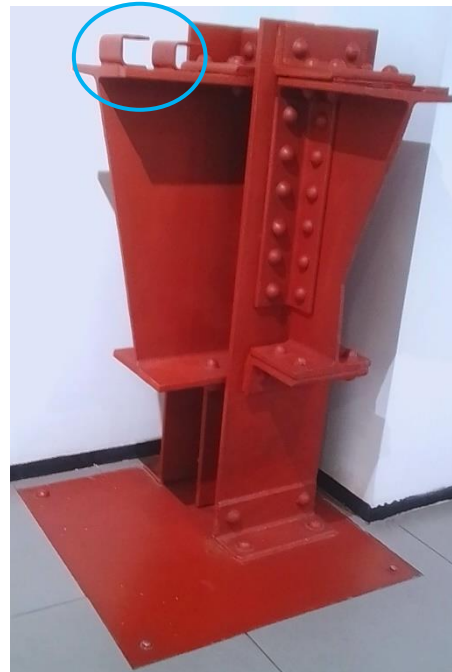
IMAGEN 100. CONECTOR DE FUERZA CORTANTE. MODELO. (FOTOGRAFÍA PROPIA, 2019)
