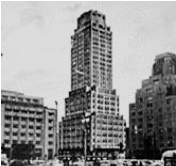
IMAGEN 59. EDIFICIO DE 27 NIVELES. (IVÁN Y CUEVAS, 2015)
