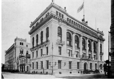
IMAGEN 29. EDIFICIO LA MUTUA. (CENTLI, 2015)
