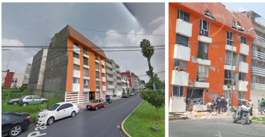
Figura 2.6 Edificio Galias 47, antes y después del sismo del 19 de septiembre de 2017.
