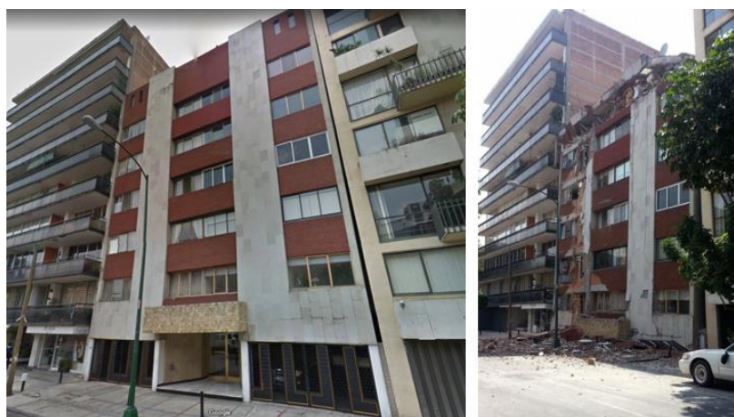
Figura 2.8 Edificio Patricio Sanz 37, antes y después del sismo del 19 de septiembre de 2017.
