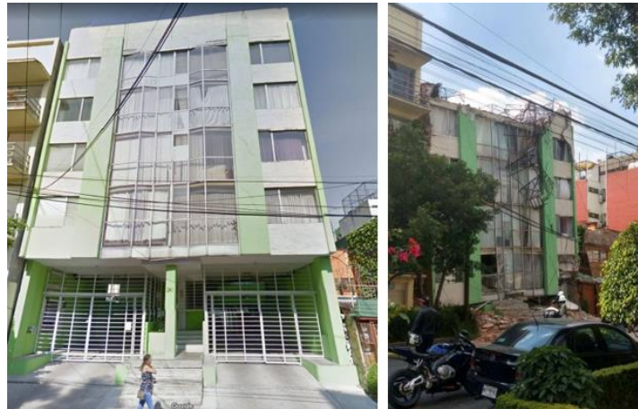
Figura 2.9 Edificio Rébsamen 241, antes y después del sismo del 19 de septiembre de 2017.
