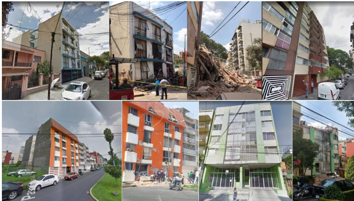
Figura 1.2 Edificios con “planta baja débil” colapsados en el sismo del 19 de septiembre de 2017 en la ciudad de México (Google maps)
