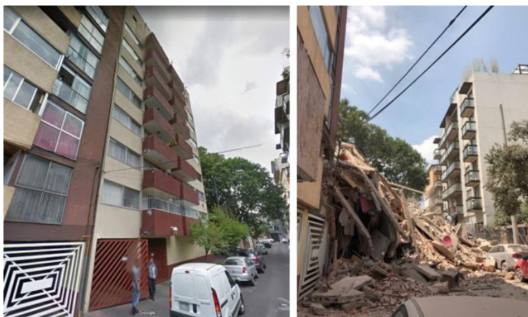
Figura 2.5 Edificio Escocia 14, antes y después del sismo del 19 de septiembre de 2017.
