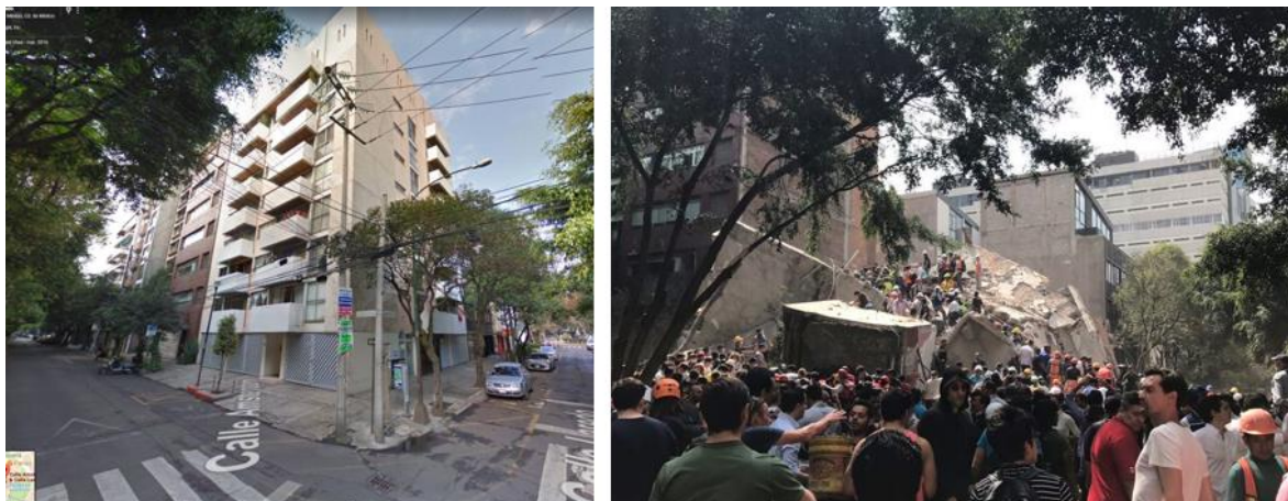
Figura 2.7 Edificio Ámsterdam 107, antes y después del sismo del 19 de septiembre de 2017.
