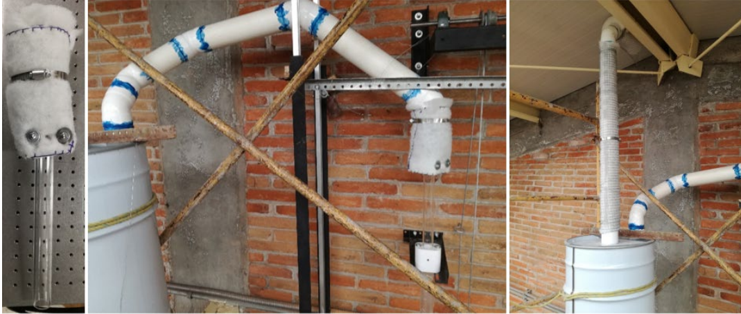
Figura 3.8.- Izquierda, se muestra el último puerto de medición con la malla metálica y con el forro para cojines, centro, instalación de separador ciclónico y derecha, se muestra el tubo de salida.
