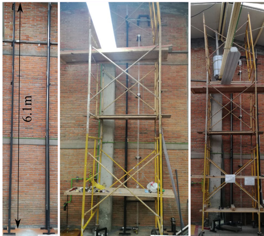
Figura 3.1.- Izquierda, estructura antes de la alineación. Centro, instalación de la tubería, Derecha, estructura fija al suelo y la pared, la distancia de separación entre las patas es de 92 cm. La estructura amarilla es un andamio para facilitar el acceso al experimento.
