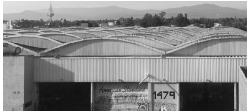
Fig. 3.9 Estación Calle 11 Fuente: Fotografía propia
