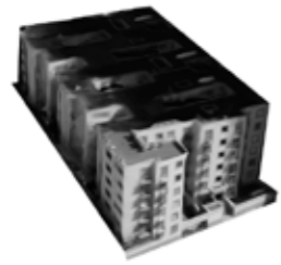
267. Fray Servando Teresa de Mier 273 Edificio de vivienda colectiva. Mala inserción
