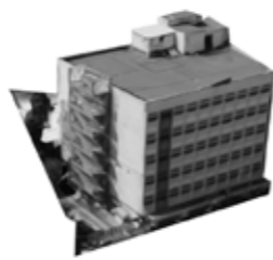
429. Av. Chapultepec 98 Edificio del metro Cuauhtémoc. Tipología siglo 20.
