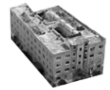
25. Gorostiza 46 Edificio de vivienda. Buena densidad y buen estado.
