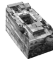
478. Versalles 84 Edificio abandonado del siglo 20.
