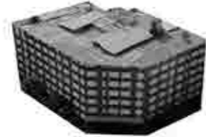
533. Versailles 46 Edificio de vivienda siglo 20, buena densidad y es correcto.
