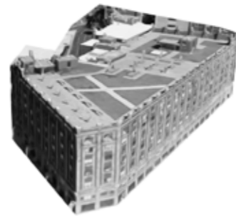
284. Tlaxcoaque 8 INAH, INBA Y SEDUVI. Edificio que funciona como oficinas de gobierno de la ciudad. Bien conservado.
