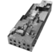
137. Nacional 17 Edificio antiguo. Aparentemente vivienda. Muy deteriorado. Puede reemplazarse.
