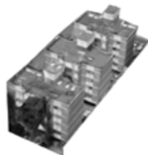
717. Sadi Carnot 7 Tres edificios de vivienda colectiva.
