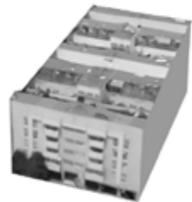
631. Serapio Rendón 81 Edificio nuevo de vivienda.
