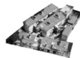
8. Constanza 34 Vecindad tipo 85, con varios edificios internos integrados por patios abiertos. Mala calidad constructiva, espacial interna y urbana.
