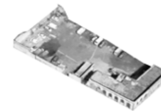
307. Bolívar 171 INAH, INBA Y SEDUVI. Hoy unido con predio trasero como estacionamiento, solamente se observa un cuerpo original en la esquina de Chimalpopoca y Bolívar.
