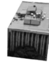
605. Serapio Rendón 114 Edificio de oficinas de segunda mitad del siglo 20.
