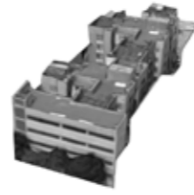
628. Serapio Rendón 95 Edificio nuevo de oficinas.
