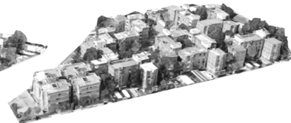
752-754. Estrella 171, Marte 140 y Marte S/N Vivienda multifamiliar del siglo 20. Supermanzana.
