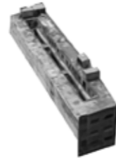
657. Miguel E. Schultz 50 Edificio de vivienda abandonado.
