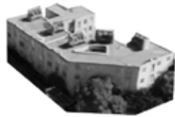
411. Carmona y Valle 34 y 36 INAH Y SEDUVI. Edificio nuevo, sin valor.
