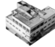
211. Zavala 13 Edificio siglo 20. Parece abandonado. Se puede reemplazar.
