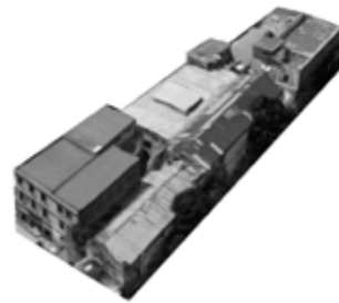
807. Zarco 255 Edificio de vivienda nueva. Actualmente en obra, hubo demolición de los edificios que todavía se ven en Google Maps.
