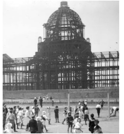
Caso de transformación en el tiempo: Palacio Legislativo Federal del arquitecto francés Émile Bénard. Su construcción se empezó en 1910 y se detuvo durante la Revolución, quedando abandonada la estructura metálica. En 1938 el arquitecto Carlos Obregón Santacilia concluye el proyecto de mausoleo dedicado a la Revolución, recuperando parte de la estructura.
