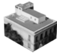
526. Lucerna 54 INAH, INBA Y SEDUVI. Edificio bien conservado.
