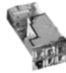
544. General Prim 70 INAH, INBA Y SEDUVI. Casa bien conservada.
