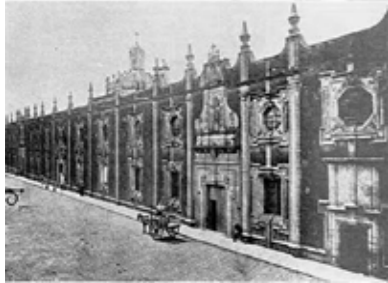
Caso de preservación en la Ciudad de México: Colegio de las Vizcaínas, 1767. Edificio que sigue funcionando como colegio y conserva sus 4 fachadas originales.
