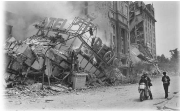
Figura 39. El hotel Regis, tras el terremoto 69 .
