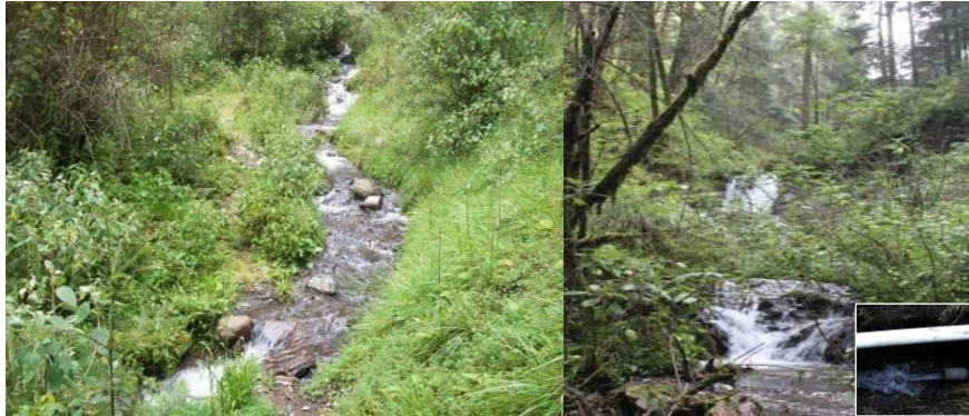
Figura 2.60 Vista del arroyo y entubamiento, en el área de Potrero propiedad de Bienes comunales de Amecamec. (LCAyE, octubre-2010, junio-2011)
