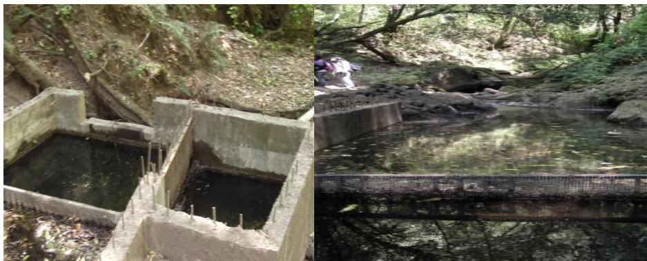
Figura 2.73 Vista de la alimentación del agua del arroyo a las cajas de agua que abastecen a Santa Isabel Chalma. (LCAy, marzo-2011; abril-2014)
