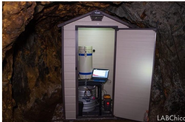
Figura 49. Fotografía de Instalación provisional en el sitio de la mina Guadalupe.
